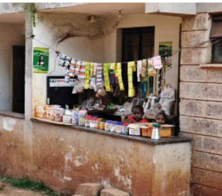
μετατροπή ισόγειου σε κατάστημα
