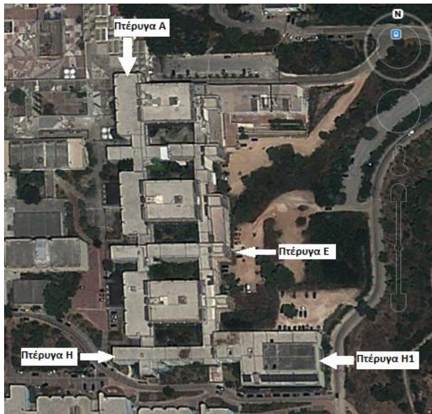
Εικόνα 5: Δορυφορική άποψη του κτιρίου των Χημικών Μηχανικών και προσανατολισμός του [Google Earth]
