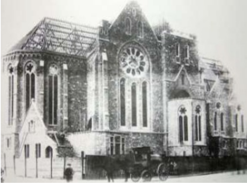
Εικόνα 5.7: Από τις εργασίες κατασκευής (IPW 3: Saint Francis Xavier Church, KU Leuven 2010-2011)
