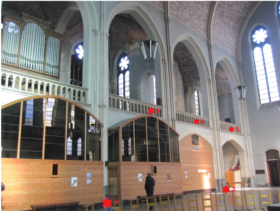
Εικόνα 5.15: Οι τεχνητοί στόχοι τοποθετημένοι στη γαλαρία
