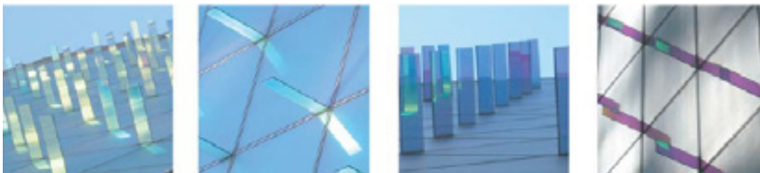
Εικόνα 2-14: Εφαρμογή διχρωμικού γυαλιού στη Νέα Υόρκη από τον αρχιτέκτονα James Carpenter, Πηγή: Michelle Addington and Daniel Schodek (2005), Smart Materials and New Technologies for architecture and other design professions. Architectural Press, σελ. 169
