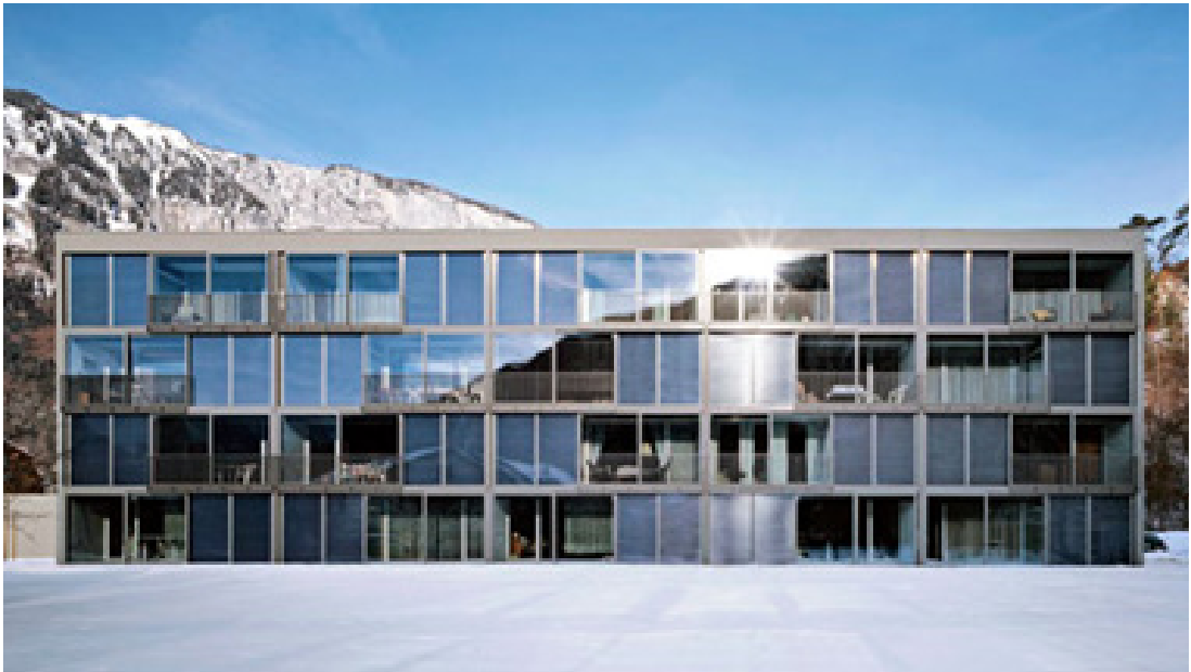
Εικόνα 3-23: Η νότια όψη του συγκροτήματος διαμερισμάτων Πηγή: http://inhabitat.com/phase-change-glassx-windows-offer-amazing-performance/glassx-lead01/
