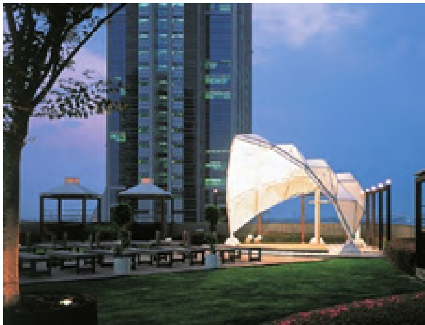
Εικόνα 3-24: Στέγαστρο από αυτοκαθαριζόμενη μεμβράνη Πηγή: Alex Ritter, (2007), smart materials in architecture, interior architecture and design. Birkhauser, σελ. 105
