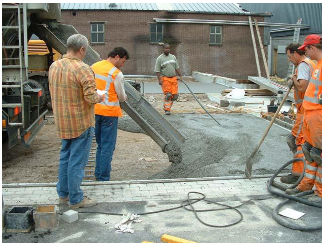
Εικόνα 3.14 Εφαρμογή οικολογικού μίγματος σκυροδέματος σε βιομηχανικό πεζοδρόμιο (Industrial pavement) Werf Heijmans Rosmalen (Fennis, 2011).
