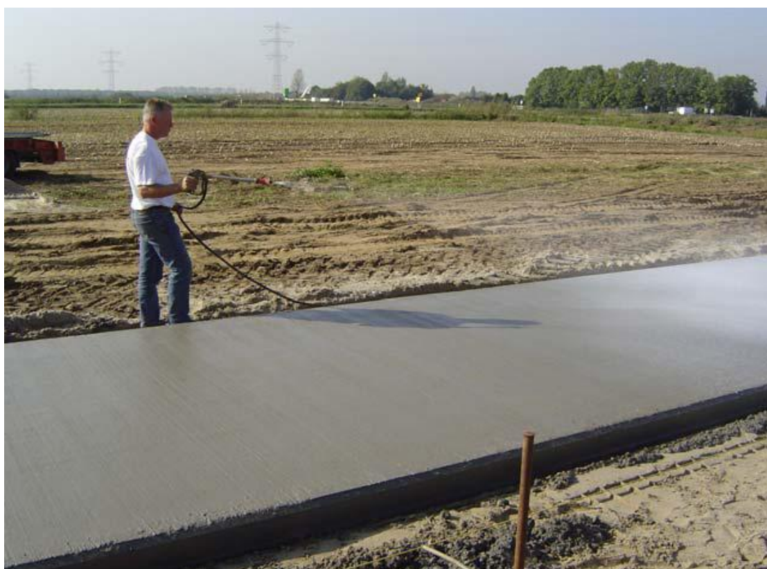
Εικόνα 3.15 Διαβροχή του οικολογικού μίγματος (Self-compacting concrete) Heembeton (Fennis, 2011).
