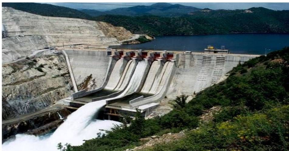
Εικόνα 3.20 Το οικολογικό φράγμα της Πλατανόβρυσης στο Νέστο ( http://flyash.com/ )
