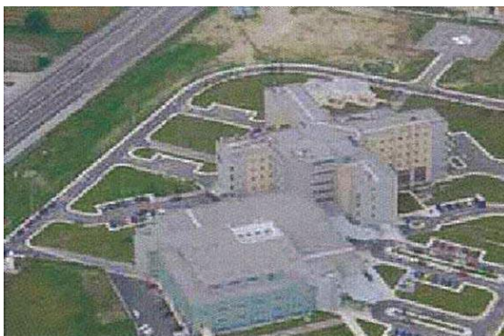
Εικ.3.5.Γενικό Νοσοκομείο Σερρών
