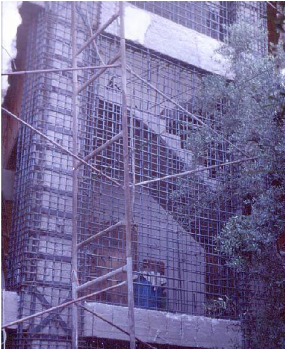
Εικόνα2.4 Προσθήκη Τοιχώματος και ενίσχυση υποστυλώματος (Αίγιο,1995)
