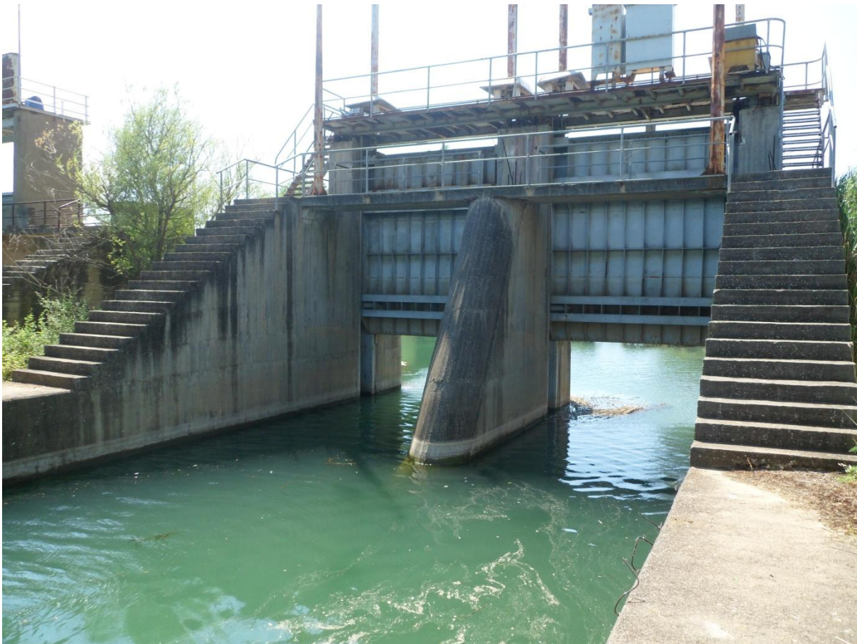
Εικόνα Α.14 Όψη μέρους του φράγματος BOOT.
