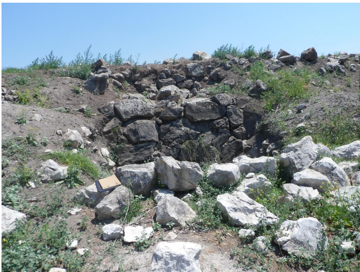
Εικόνα 6.3 Όψη του τοίχου αντιστήριξης του ανεσκαμμένου αναχώματος στη θέση «Άντερας» (περί τα 6 km ανατολικά του Ορχομενού).
