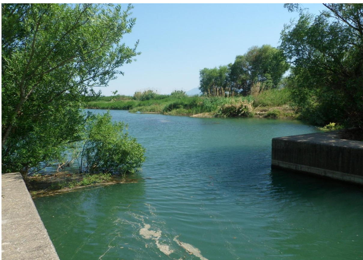
Εικόνες Α.15 και Α.16 Φωτογραφίες από το φράγμα ΒΟΟΤ.
