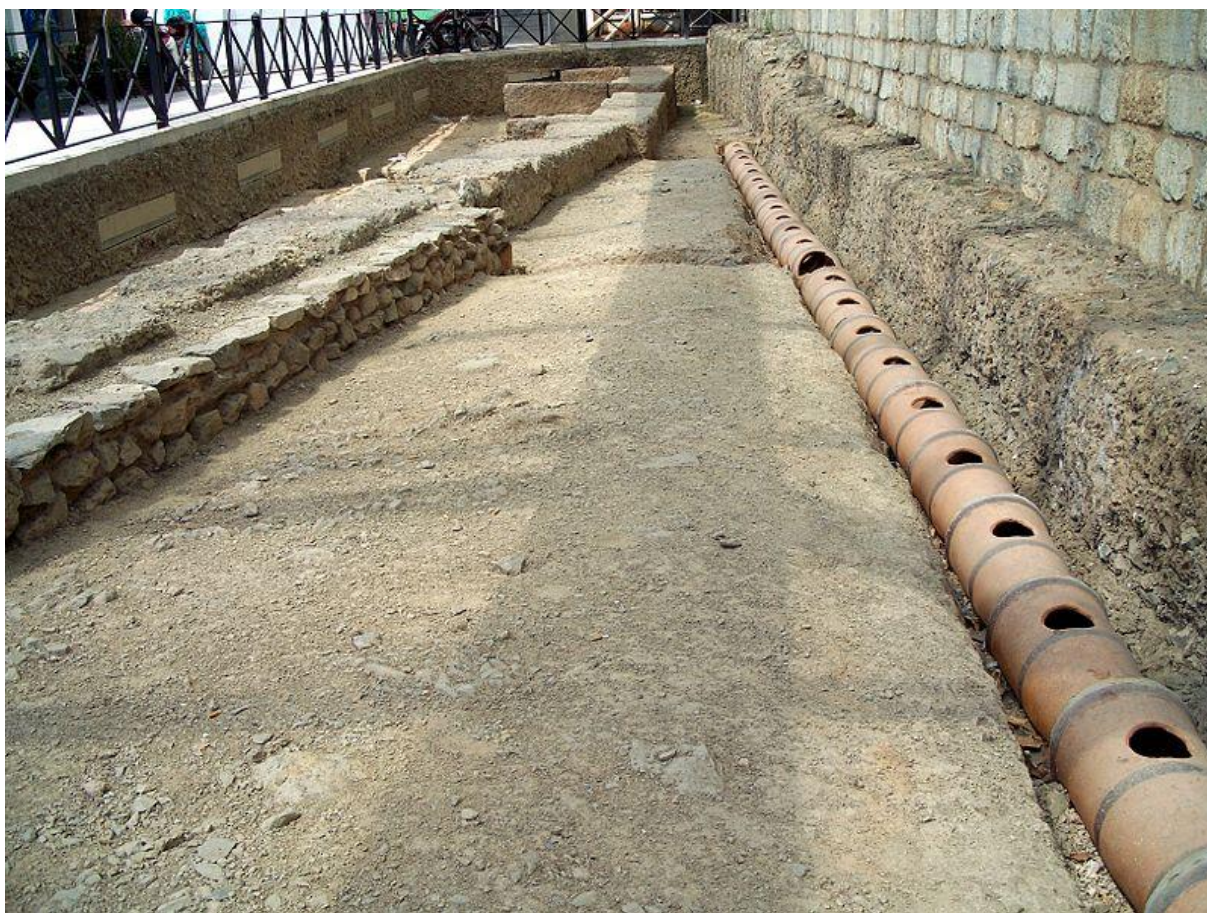
Εικόνα 2.2 Τμήμα του Πεισιστράτειου υδραγωγείου που ανακαλύφθηκε κατά τις εργασίες κατασκευής του Μετρό στην Πλατεία Συντάγματος. Πηγή:
