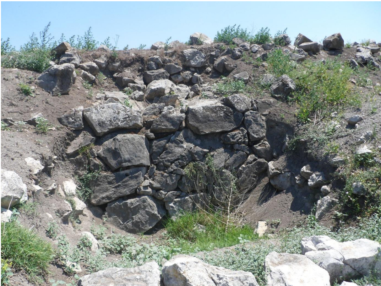
Εικόνα Α.8 Ο αναλημματικός τοίχος του Μινυακού αναχώματος.
