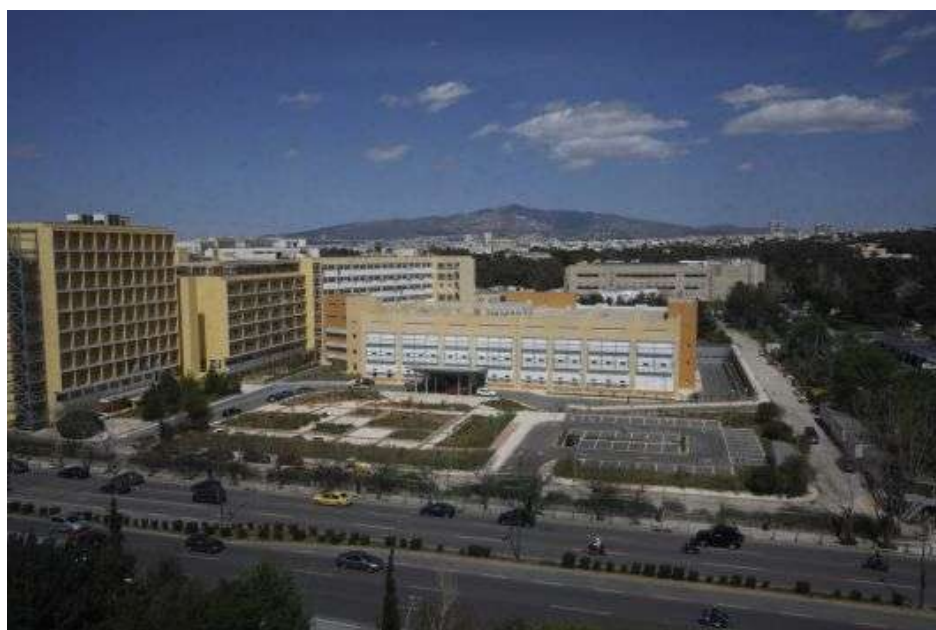
Εικόνα 8.2 Νέα πτέρυγα 401 ΓΣΝΑ
