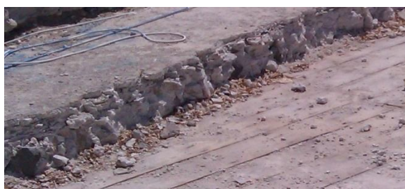
Σχ.3.1.1.1 φωτογραφίες αποκάλυψης του παλαιού δώματος κατά την πρόσφατη περίοδο των εργασιών αντικατάστασής του
