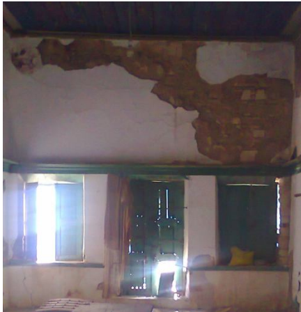
Σχ.5.4.4 παρουσία υγρασίας στο εσωτερικό επίχρισμα
