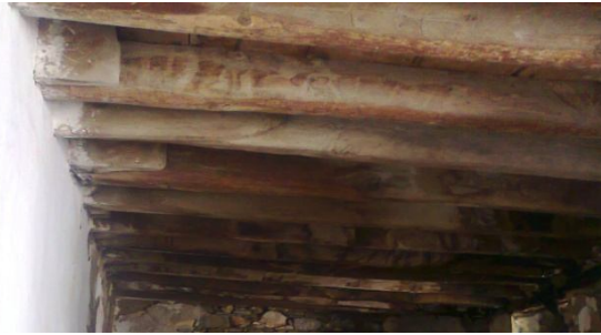
Σχ.2.3.2 οροφή στο τραπεζοειδές τμήμα – όροφος στάθμης +7.59
