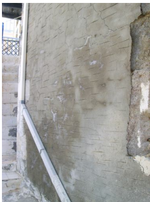
Σχ.5.4.3 δίκτυο ρωγμών – αποκόλληση λίθων – διάβρωση πορώλιθων
