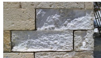
Σχ.5.4.3 δίκτυο ρωγμών – αποκόλληση λίθων – διάβρωση πορώλιθων
