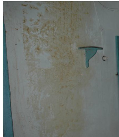
Σχ.5.4.4 παρουσία υγρασίας στο εσωτερικό επίχρισμα
