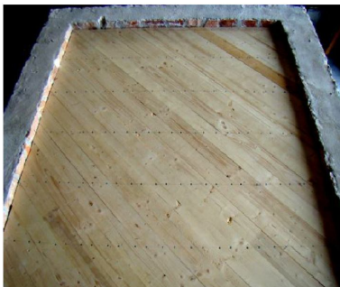
Σχ. 9.3.1 δεύτερο σανίδωμα υπό 45° & σύνδεση δώματος με τους περιμετρικούς τοίχους
