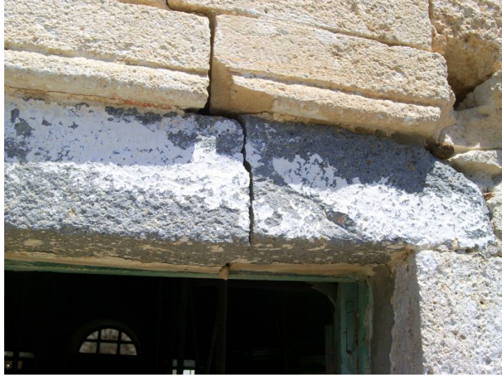
Σχ.5.4.2 σχετική μετακίνηση υπερθύρων
