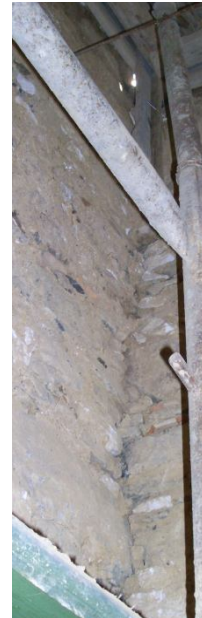
Σχ. 9.2.2.2 νότιο τοίχος ρωγμή P1 – αποκόλληση με διασταυρούμενο τοίχο
