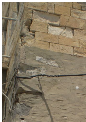
Σχ.5.4.3 δίκτυο ρωγμών – αποκόλληση λίθων – διάβρωση πορώλιθων
