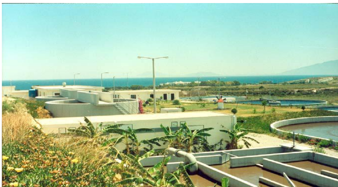
Άποψη από το Βιολογικό καθαρισμό της Κω Πηγή : Δίκτυο Αειφόρων Νήσων Αιγαίου
