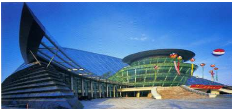
Εικόνα 5(Grand theatre στο Hangzhon της Κίνας)
