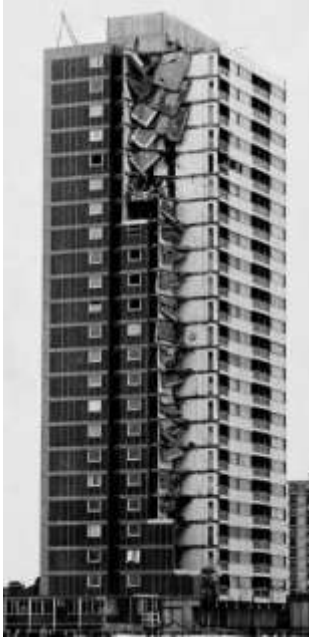
Εικόνα 6(Το Ronan Point μετά τη μερική κατάρρευση)
