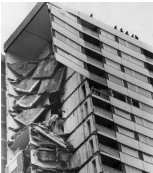
Εικόνα 7(Η κατάρρευση της γωνίας του Ronan Point)
