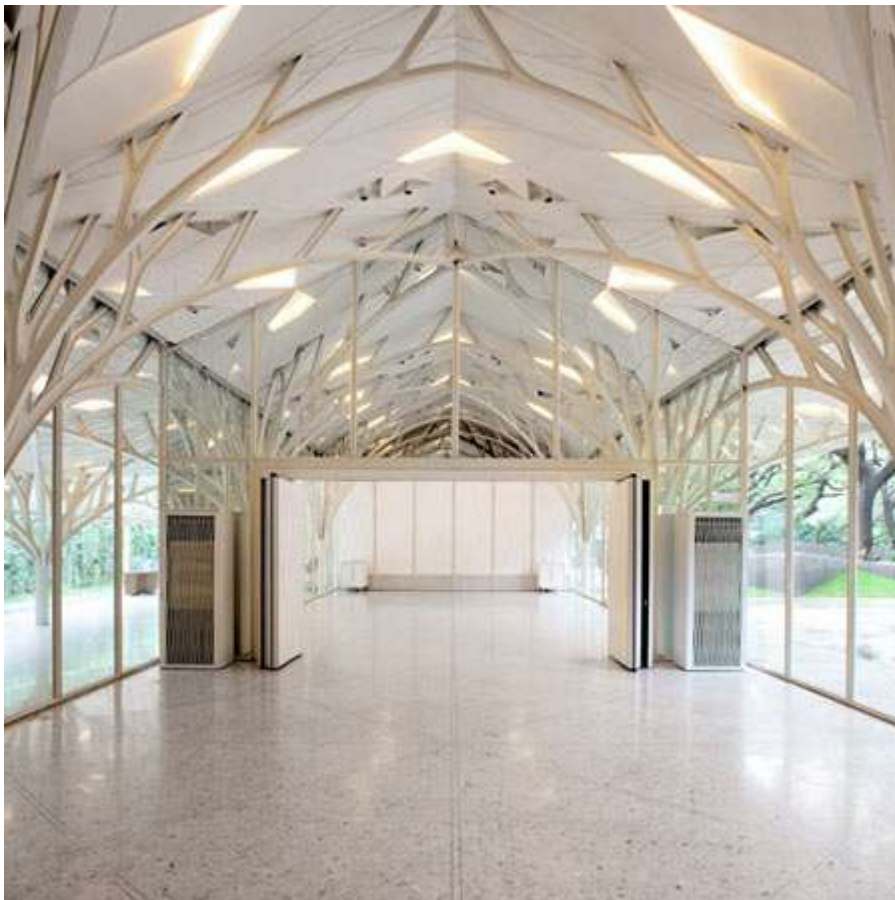
Εικόνα 3 (Μεταλλικός δενδροειδής φέρων οργανισμός ως προσθήκη στο υπάρχον κέλυφος, στο χώρο "The Tote" στη Βομβάη)
