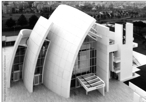
Εικόνα 4.1. Φωτογραφία της καθολικής εκκλησίας Dives in Misericordia της Ρώμης. Δείγμα εφαρμογής της φωτοκαταλυτικής τεχνολογίας σε δομικά υλικά.
