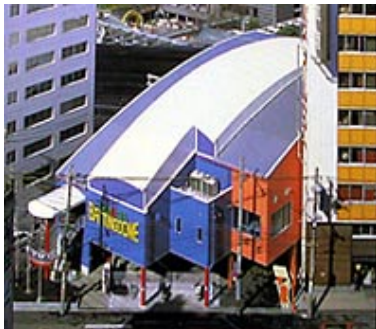
Εικόνα 4.4. Εφαρμογή υπερυδρόφιλων επικαλύψεων σε στέγη σιδηροδρομικού σταθμού στην Ιαπωνία (Taiyo Kogyo Corporation)
