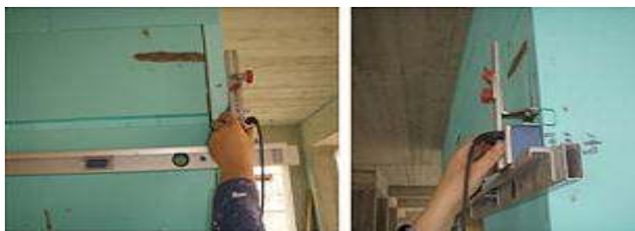
Εικόνα 33: Απεικόνιση σταδίων διαδικασίας εφαρμογής εσωτερικής θερμομόνωσης
