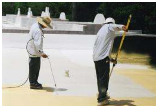
Εικόνα 8: Επίστρωση επαλειφόμενου στεγανωτικού υλικού σε ταράτσα
