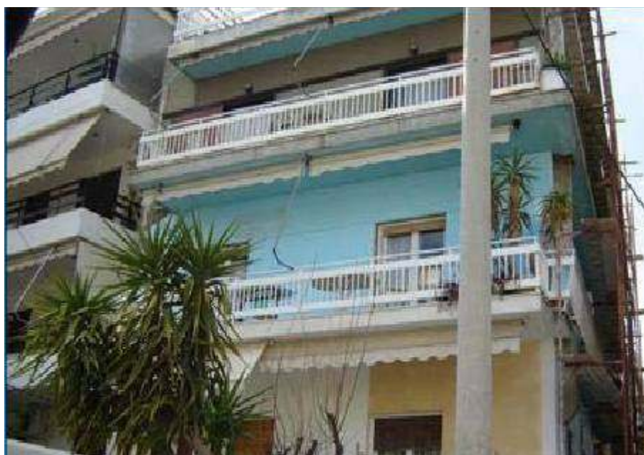
Εικόνα 31: Εφαρμογή εξωτερικής θερμομόνωσης
