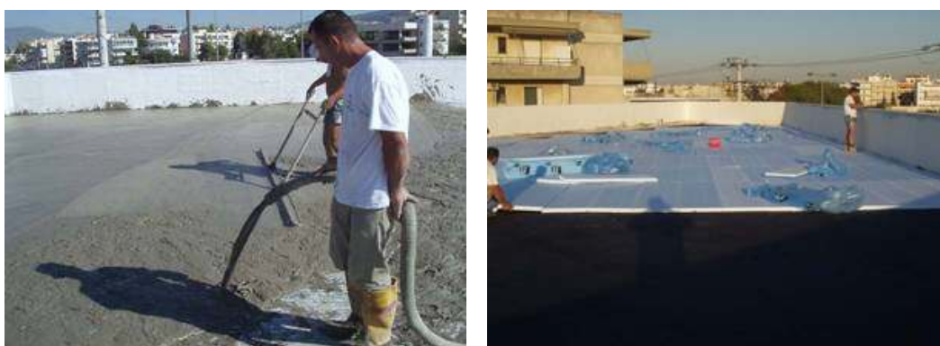
Εικόνα 6: Διαδικασία διαμόρφωσης ρύσεων και στεγανοποίησης σε ταράτσα
