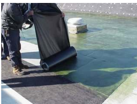
Εικόνα 10: Τοποθέτηση συνθετικής μεμβράνης σε ταράτσα
