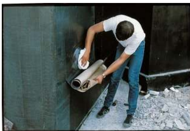
Εικόνα 9: Τοποθέτηση ασφαλτικής μεμβράνης σε τοίχο
