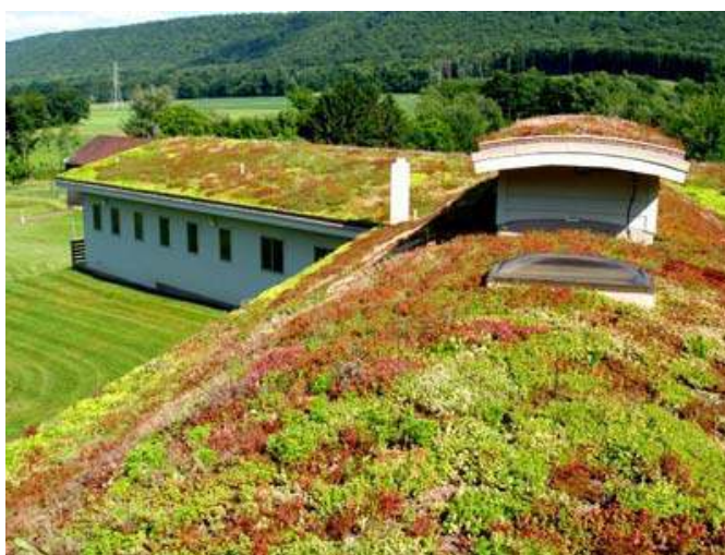
Εικόνα 15: Εκτατικός τύπος φυτεμένου δώματος
