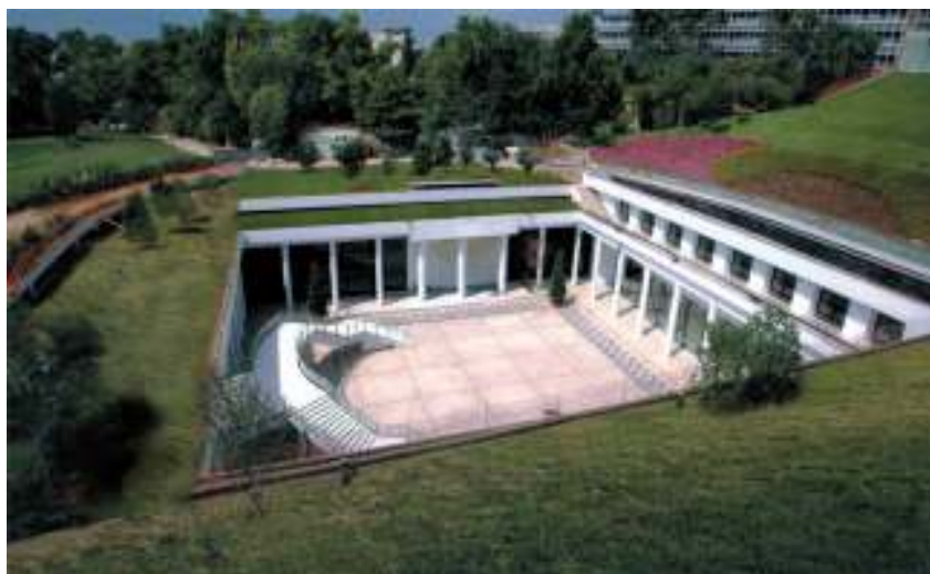
Εικόνα 16: Εντατικός τύπος φυτεμένου δώματος
