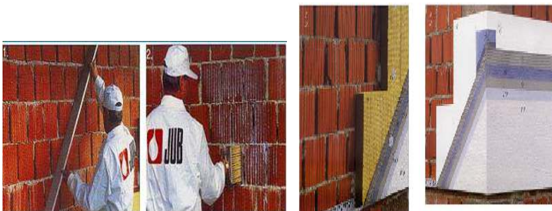
Εικόνα 32: Διαγραμματική απεικόνιση εφαρμογής εσωτερικής θερμομόνωσης
