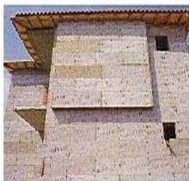
Εικόνα 28: Ολική εξωτερική θερμομόνωση
