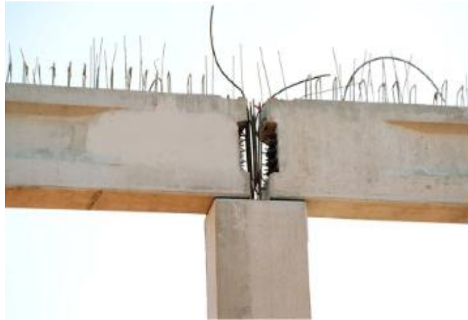
Σχήμα 3.4: Αρθρωτή σύνδεση δοκών-υποστυλώματος
