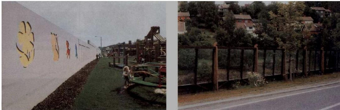
Ηχοπέτασμα δίπλα από παιδότοπο(αριστερά) και διαφανές ηχοπέτασμα με ξύλινα στοιχεία για περιορισμό της αλλοίωσης της άποψης του περιβάλλοντος(δεξιά)
