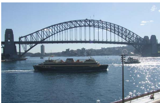
Σχήμα 1.3: Τύποι γεφυρών βάσει μόρφωσης κύριων δοκών: (α) Δικτυωτή (Sydney), (β) Ολόσωμη (Ρήνου)
