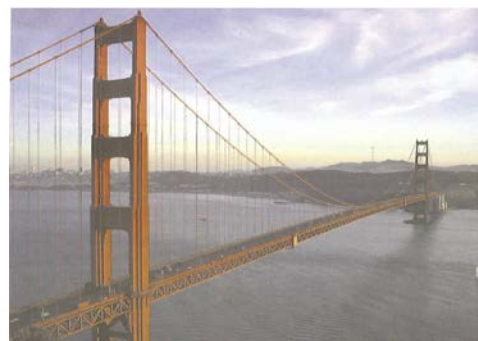
Σχήμα 1.2: Τύποι γεφυρών βάσει στατικής λειτουργίας: (α) Τοξωτή (Ιαπωνία), (β) Κρεμαστή (San Francisco)
