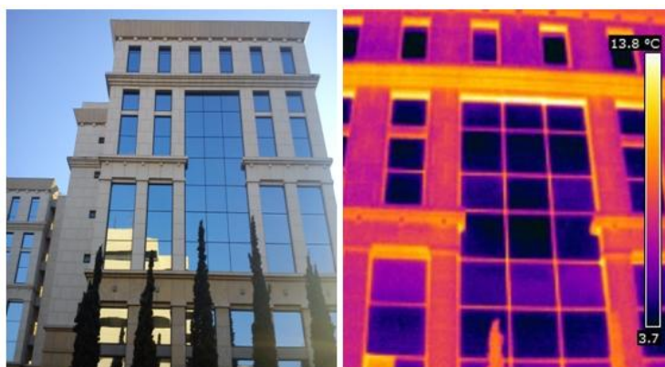
Εικόνα 4.8: Νότια όψη του κτιρίου (πτέρυγα Α)
