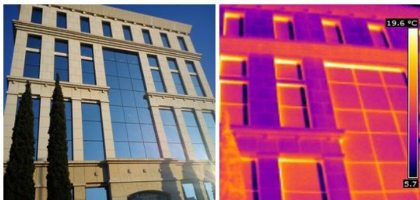
Εικόνα 4.9: Ανατολική όψη του κτιρίου
