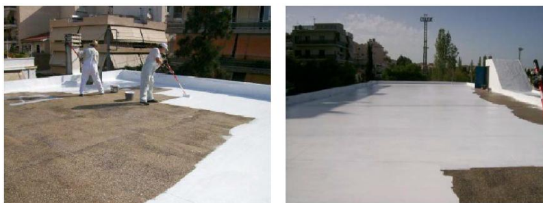
Εικόνα 5.1: Εφαρμογή του ψυχρού υλικού σε στέγη κτιρίου
