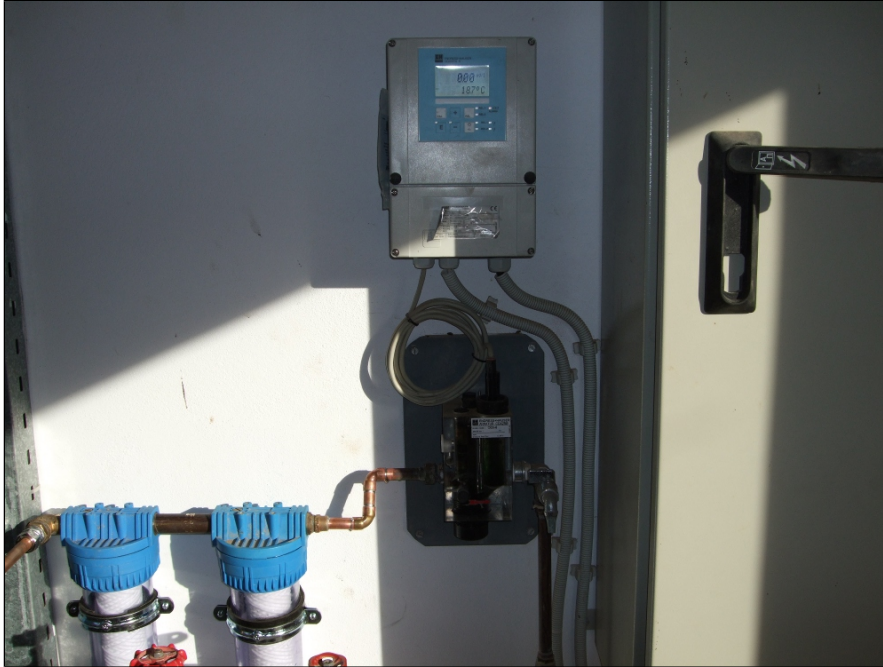
Σχήμα 1.12: Στην εικόνα διακρίνεται ο μετρητής υπολειμματικού χλωρίου και το φίλτρο των εισερχόμενων λυμάτων σε αυτό.
