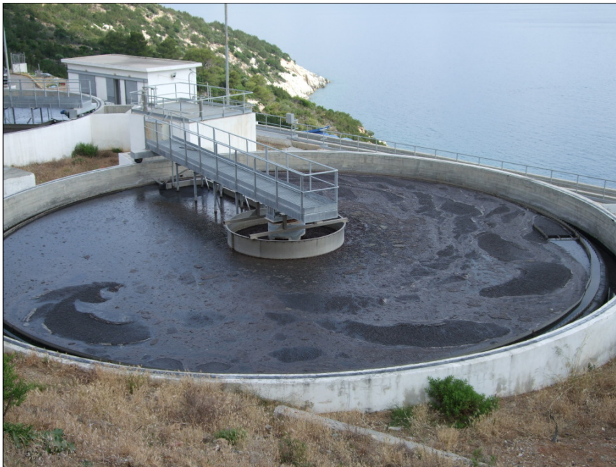
Σχήμα 1.14: Επιπλέουσα λυματολάσπη στην επιφάνεια της μιας εκ των δύο δεξαμενών καθίζησης, με αποτέλεσμα την υποβαθμισμένη ποιότητα εκροής της εγκατάστασης.
