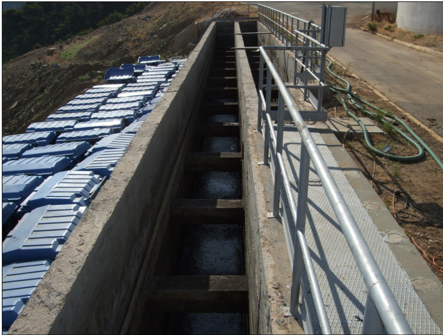
Σχήμα Β΄.5: Κενή δεξαμενή χλωρίωσης
