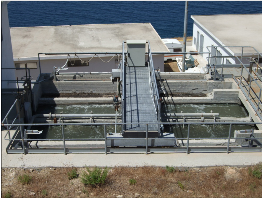
Σχήμα Β΄.1: Γέφυρα εξάμμωσης
