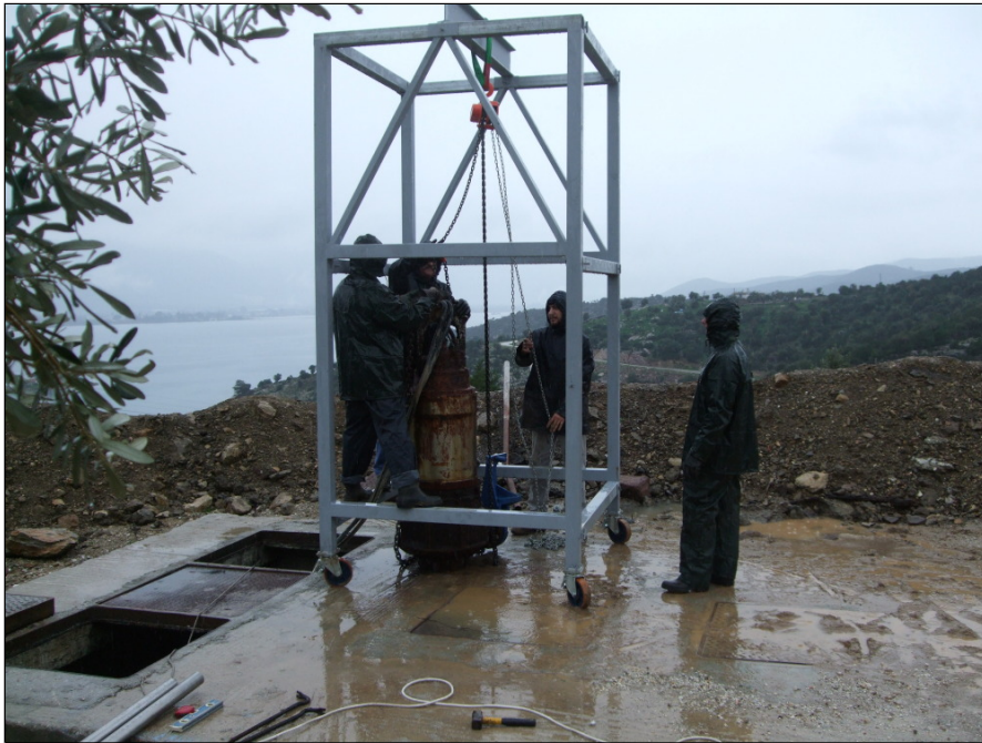
Σχήμα Β΄.7: Τοποθέτηση αντλίας λυμάτων στο αντλιοστάσιο Α4.2 της περιοχής Ρωσικός Ναύσταθμος.
