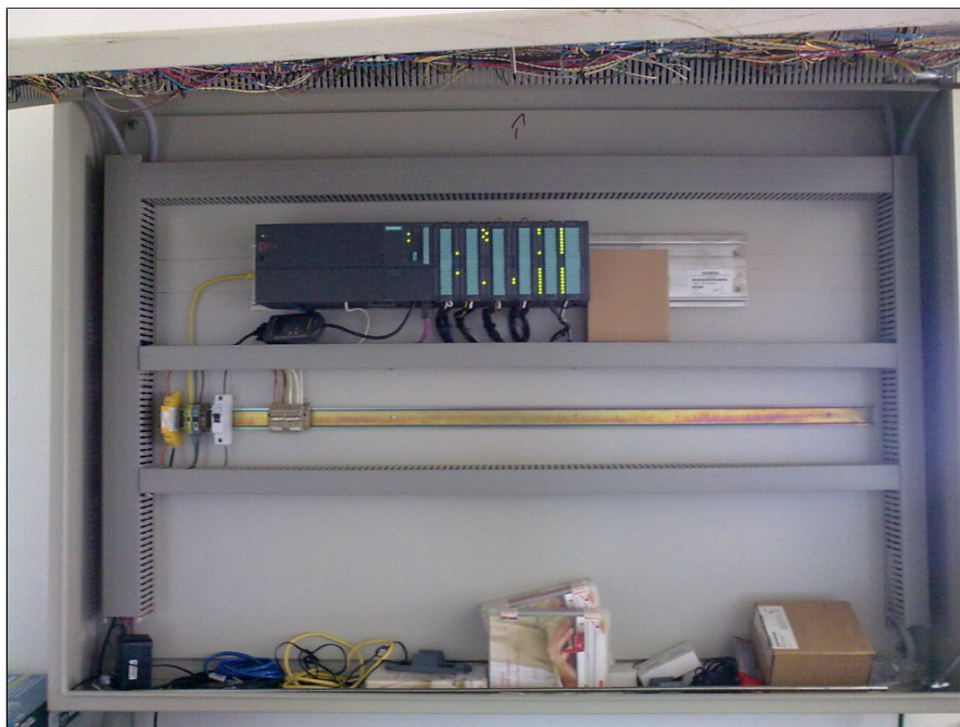
Σχήμα 1.3: Το PLC S7-300 της Siemens που στεγάζεται στον κεντρικό ηλεκτρολογικό πίνακα εντός του κτιρίου διοίκησης.
