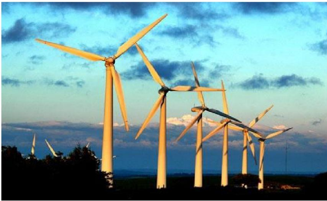
Εικόνα 1.1.2 Αιολικό πάρκο Ρόδου
