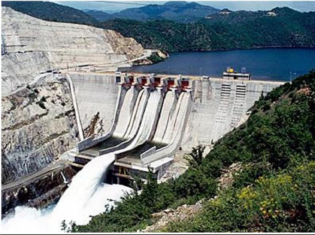
Εικόνα 1.1.1 Υδροηλεκτρικός σταθμός Πλατανόβρυσης Δ.Ε.Η.
