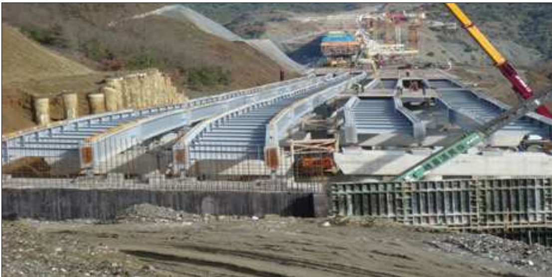
Εικόνα 1. 11: Κατάστρωμα με δύο κύριες δοκούς
