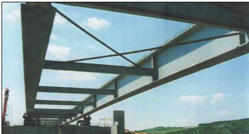
Εικόνα 1. 13: Οριζόντιοι σύνδεσμοι σιδηροδοκών
