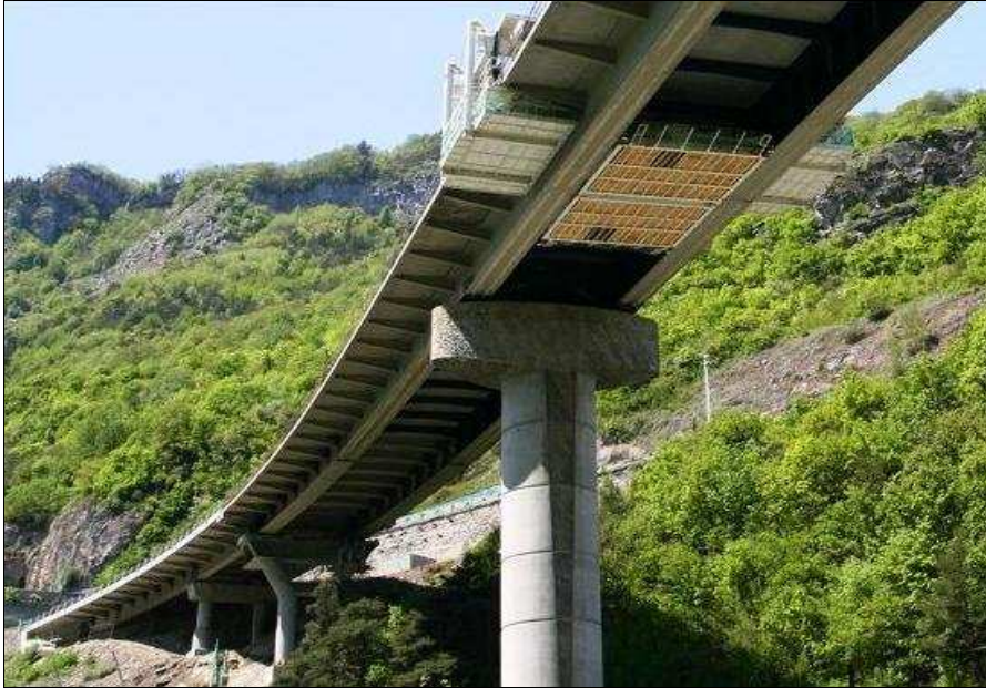
Εικόνα 1. 7: Κάτω όψη καταστρώματος σύμμικτης γέφυρας
