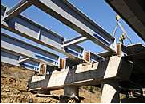
Εικόνα 1. 12: Καταστρώματα με κύριες δοκούς τύπου I
