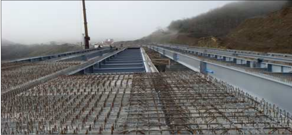
Εικόνα 1. 8: Προετοιμασία καταστρώματος σύμμικτης γέφυρας
