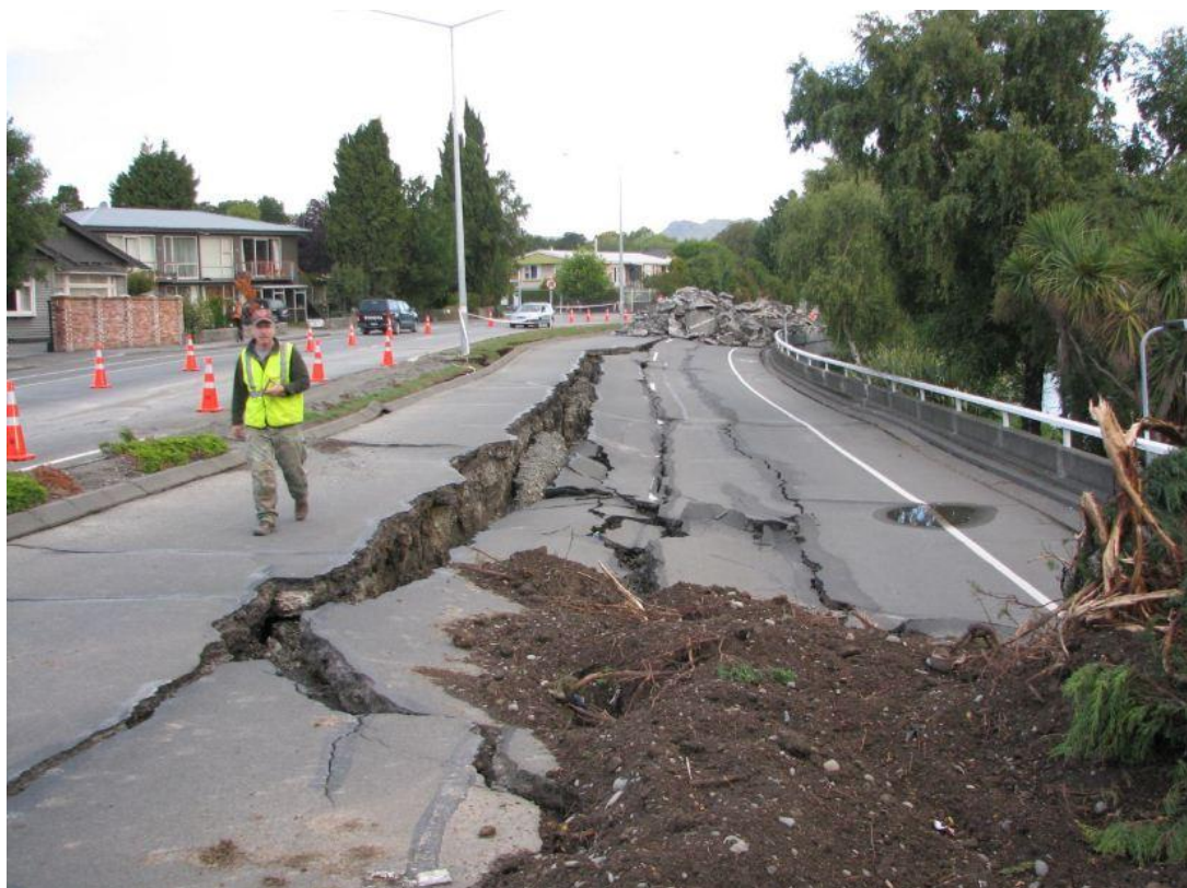
Εικόνα 3.15: προβλήματα σε γέφυρες εξαιτίας της πλευρικής εξάπλωσης του εδάφους στο Christchurch λόγω ρευστοποίησης, (πηγή: Russell A. Green, Ιούνιος 2011)
