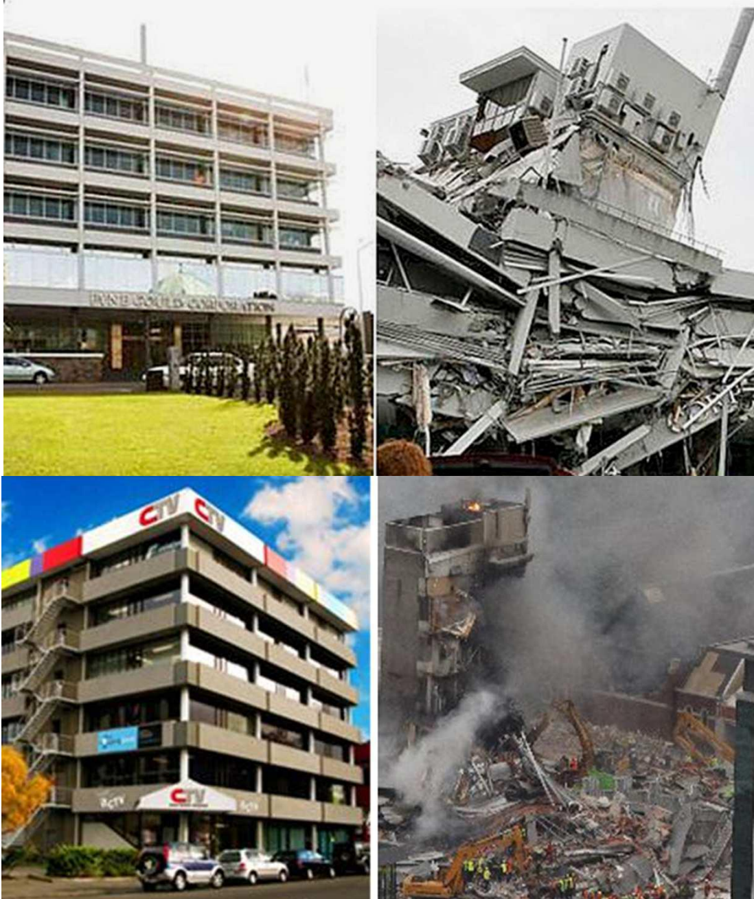
Εικόνα 2.26: πλήρης κατάρρευση δύο κτηρίων στο κέντρο του Christchurch (CBD), του Canterbury Television (CTV) και του Pyne Gould Corporation (PGC), από τον σεισμό της 22 ης Φεβρουαρίου του 2011
