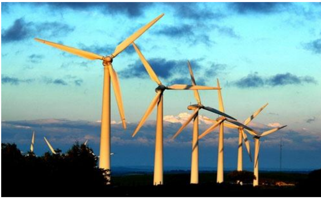
Εικόνα 1.1.2 Αιολικό πάρκο Ρόδου
