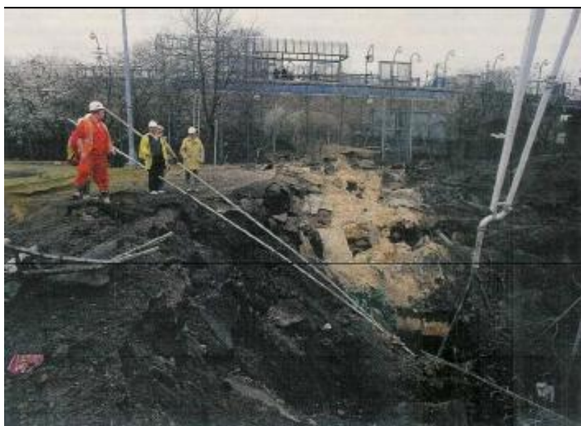
Εικόνα 1–11, Η έκρηξη του συμπιεσμένου αέρα δημιούργησε ένα τεράστιο κρατήρα στο προάυλιο ενός σχολείου, Πηγή: ICE 1998a
