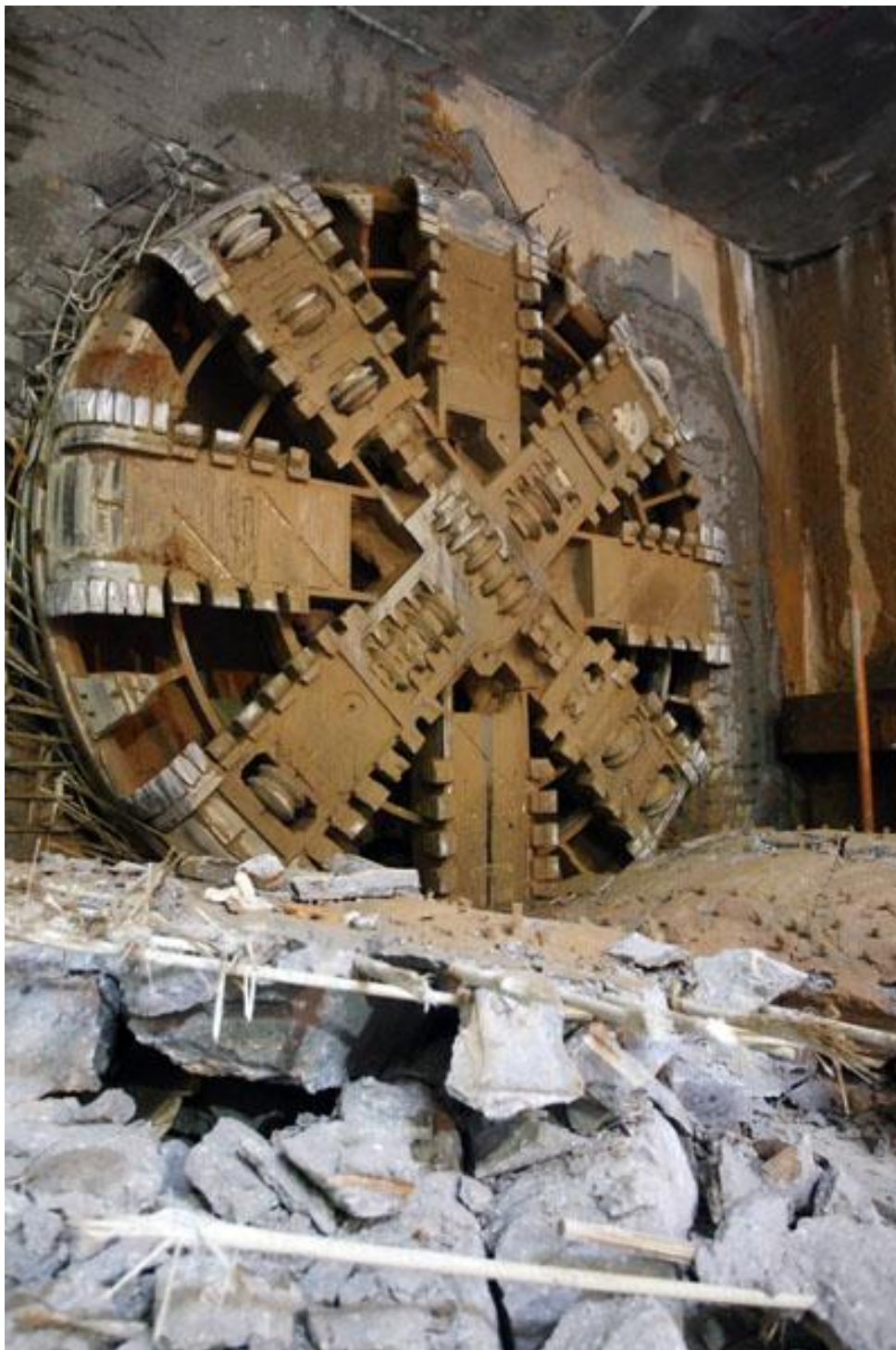
Εικόνα 3-1, Κεφαλή μηχανήματος EPB σε ξετρύπημα σταθμού, Πηγή: Σ. Κουκουτάς
