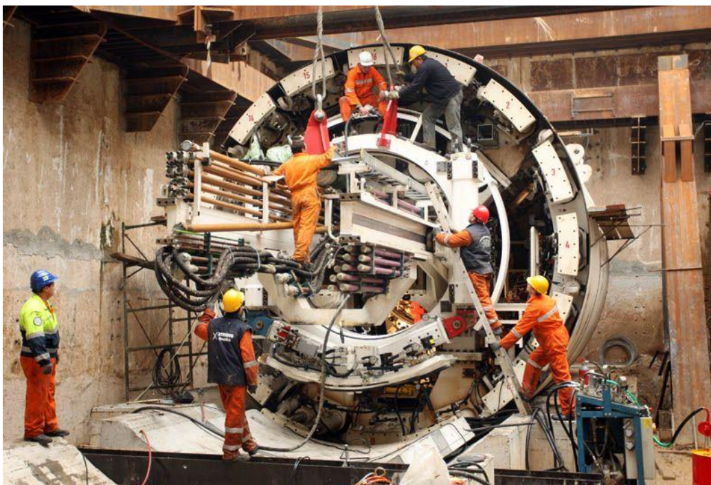
Εικόνα 1–3, Συναρμολόγηση του μηχανήματος EPB στο Μετρό Θεσσαλονίκη, Πηγή:
