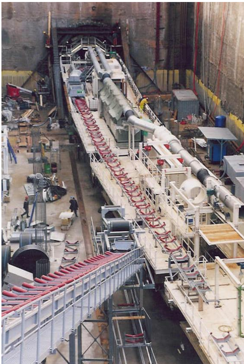
Εικόνα 3–6, Σύστημα μεταφορικής ταινίας, Πηγή: Σ. Κουκουτάς
