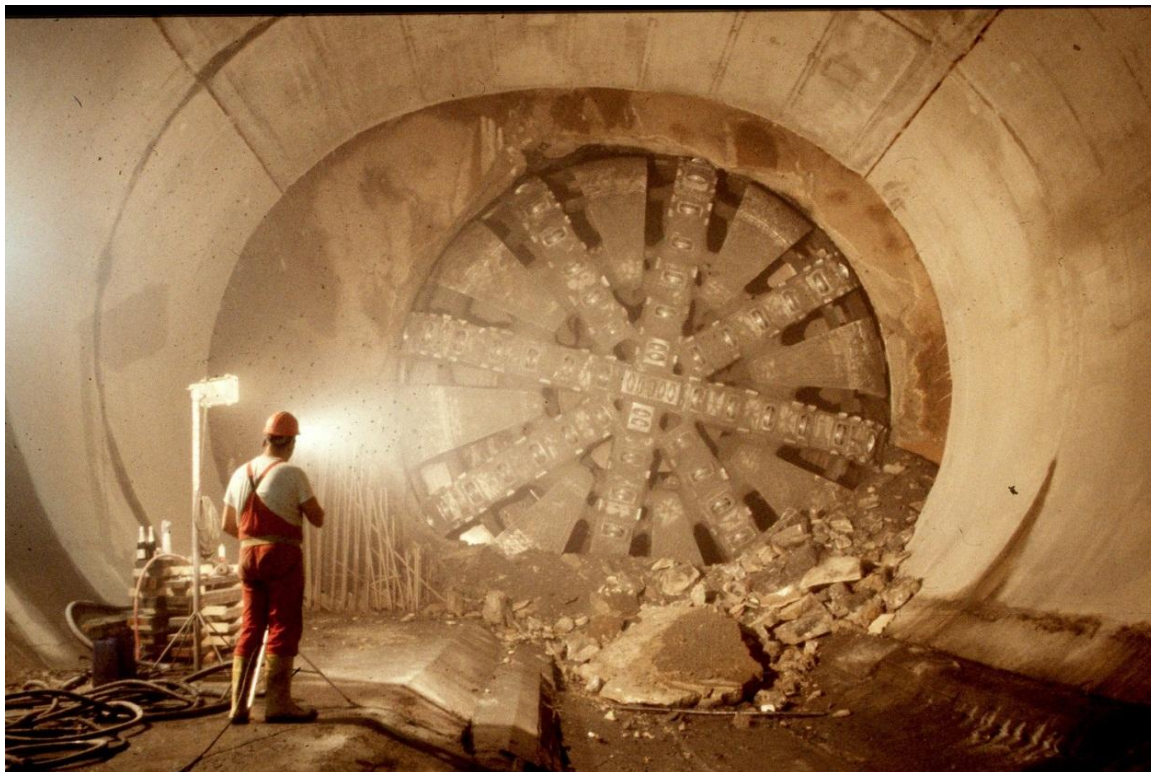
Εικόνα 3–7, Ξετύπωμα μηχανήματος EPB σε σταθμό του Μετρό της Αθήνας, Πηγή: Σ. Κουκουτάς
