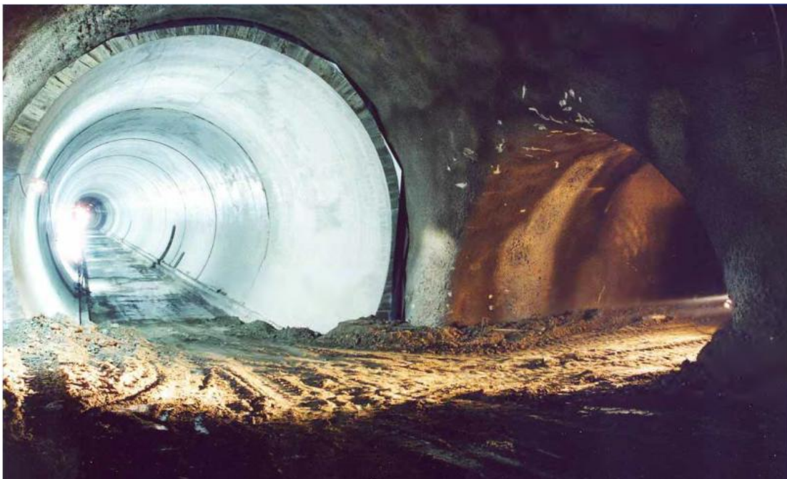
Εικόνα 10: Δίδυμη σήραγγα Καλλίδρομου μήκους 9 χλμ. Σύνδεση κλάδου κύριας σήραγγας με συνδετήρια
