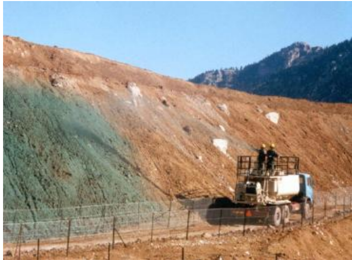
Εικόνα 15: Υδροσπορά σε μεταλλείο βωξίτη του νομού Φωκίδας
