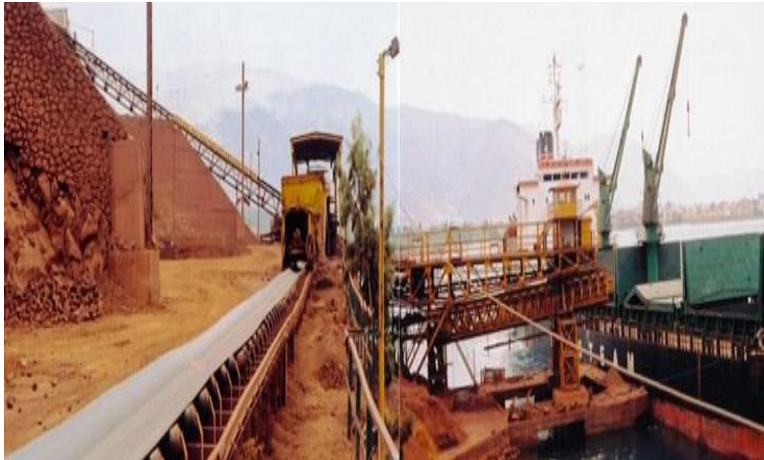
Εικόνα 17: Εγκαταστάσεις επεξεργασίας-φόρτωσης βωξίτη στην Ιτέα
