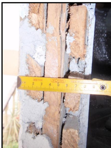
Εικόνα 11: Τρόπος κατασκευής των εσωτερικών διαχωριστικών τοίχων
