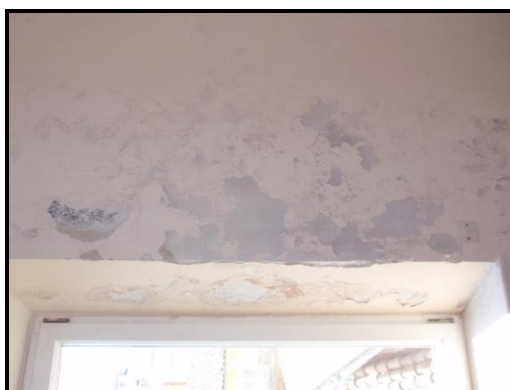
Εικόνα 23: Διαβρωμένο επίχρισμα από υγρασία
