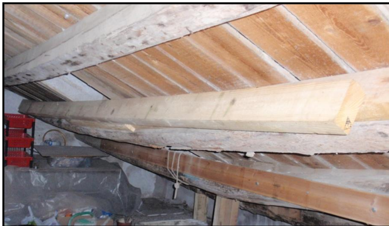
Εικόνα 19: Ενισχυμένες ξύλινες δοκοί στέγης
