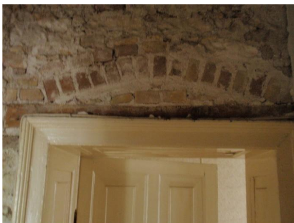
Εικόνα 15: Ξύλινο στοιχείο και ανακουφιστικό τόξο σε εσωτερικό ανώφλι
