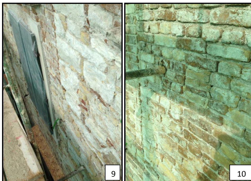
Εικόνα 8: Λιθοδομή και οπτοπλινθοδομή στο μέσο πεσσού του πρώτου ορόφου Εικόνα 9: Διαφορετικές στάθμες οπτοπλινθοδομής σε πεσσό του δευτέρου ορόφου
