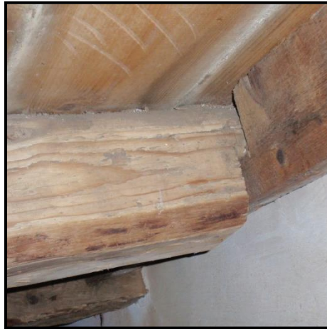
Εικόνα 18: Έδραση δοκού στέγης μειωμένης διατομής
