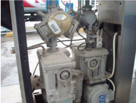
Σχήμα 41: Μετρητικό συγκρότημα αντλίας πρατηρίου και διαδικασία ελέγχου του με χρήση λιτρομέτρου.
