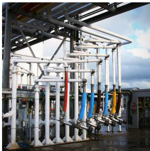
Σχήμα 5: Νησίδα φόρτωσης από τον πυθμένα 6 βραχιόνων, 4 προϊόντων με ανάκτηση ατμών
