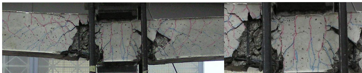
Εικόνα 23: Δοκός Δ5: Ρηγματωμένη κατάσταση φορέα μετά τη διαρροή
