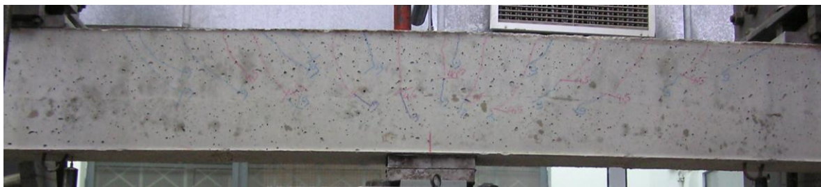
Εικόνα 14: Δοκός Δ2: εμφάνιση κεκλιμένων ρωγμών εντός διαμητικού μήκους
