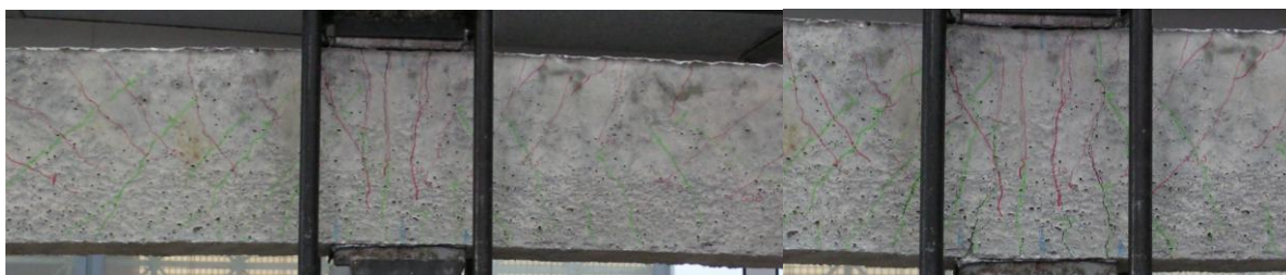
Εικόνα 18: Δοκός Δ3: Ρωγμές εντός διαμητικού μήκους. Συγκέντρωση ρωγμών στο σημείο επιβολής της φόρτισης
