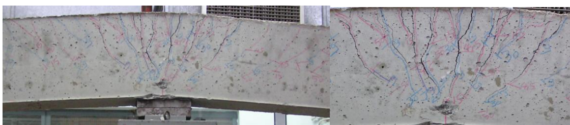
Εικόνα 15: Δοκός Δ2: συγκέντρωση καμπτοδιαμητικών ρωγμών στο σημείο επιβολής της φόρτισης
