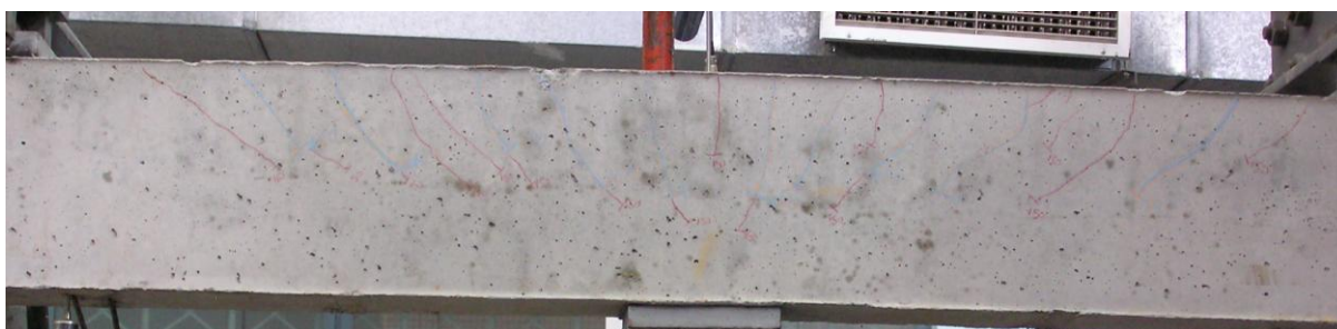
Εικόνα 11: Δοκός Δ1: εμφάνιση κεκλιμένων ρωγμών εντός διαμητικού μήκους
