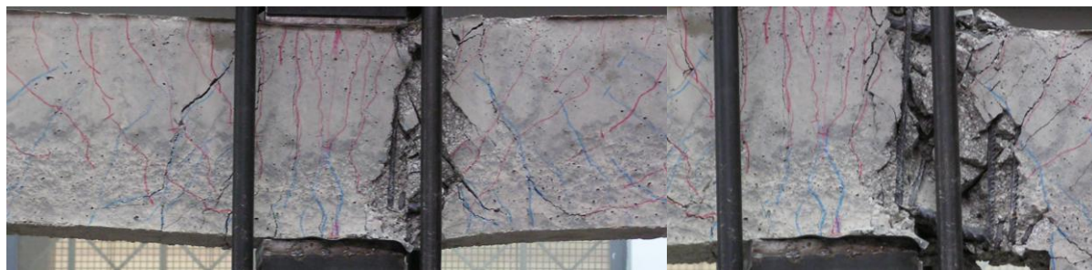
Εικόνα 21: Δοκός Δ4: Ρηγματωμένη κατάσταση φορέα μετά τη διαρροή
