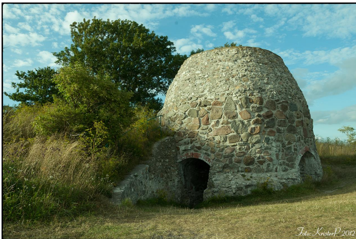
Εικόνα 2.1. Σωροκαμίνι παρασκευής ασβέστη. Δυνατότητες παρασκευής μικρών ποσοτήτων και μόνο όπου είναι δύσκολη η μεταφορά υδρασβέστου (ορεινές περιοχές).
