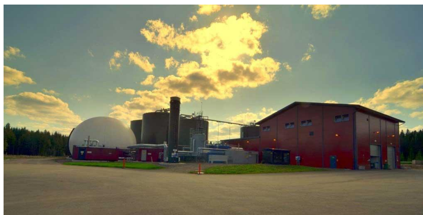
Σχήμα 2.14. Μονάδα αναερόβιας χώνευσης (Ληθαίος Ενεργειακή Α.Ε.)
