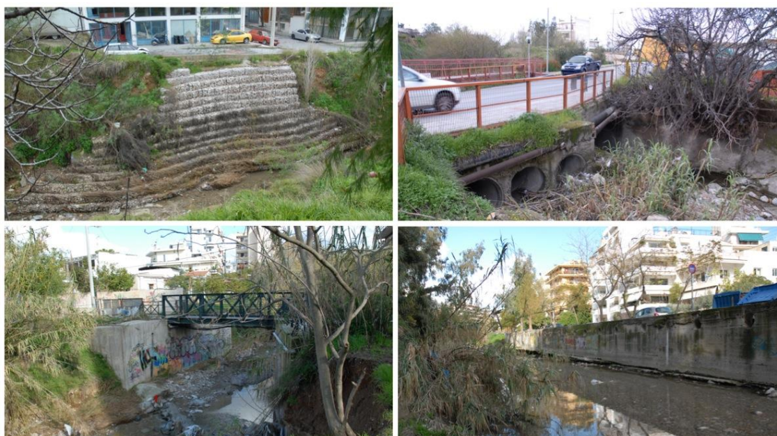
Εικόνα 16: Τεχνικά έργα στο ρέμα Πικροδάφνης
