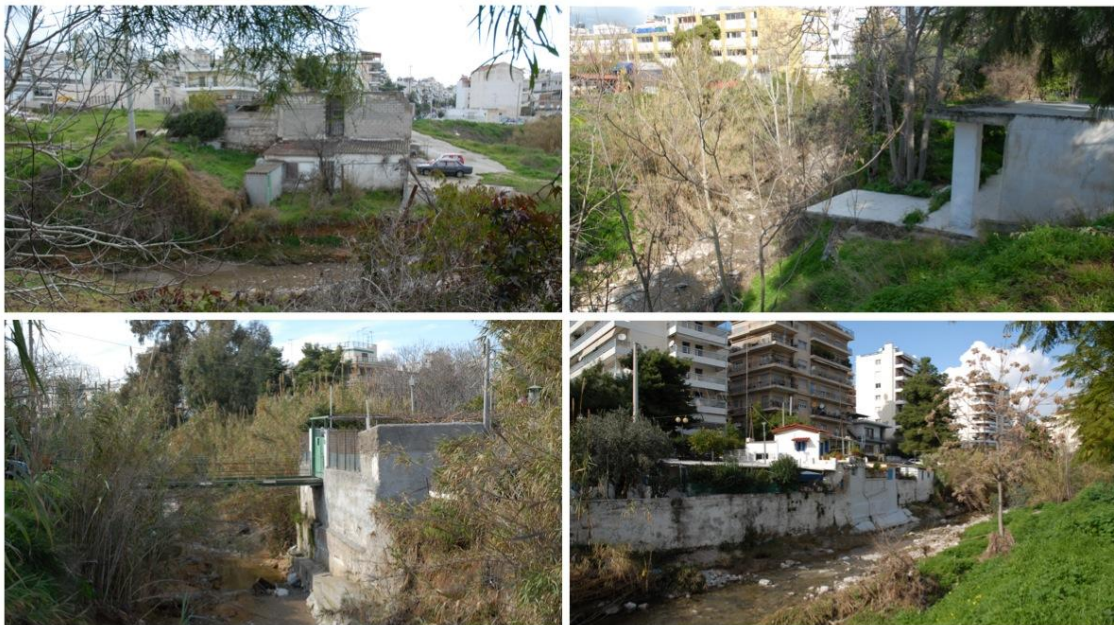
Εικόνα 18: Αυθαίρετες κατασκευές στο ρέμα
