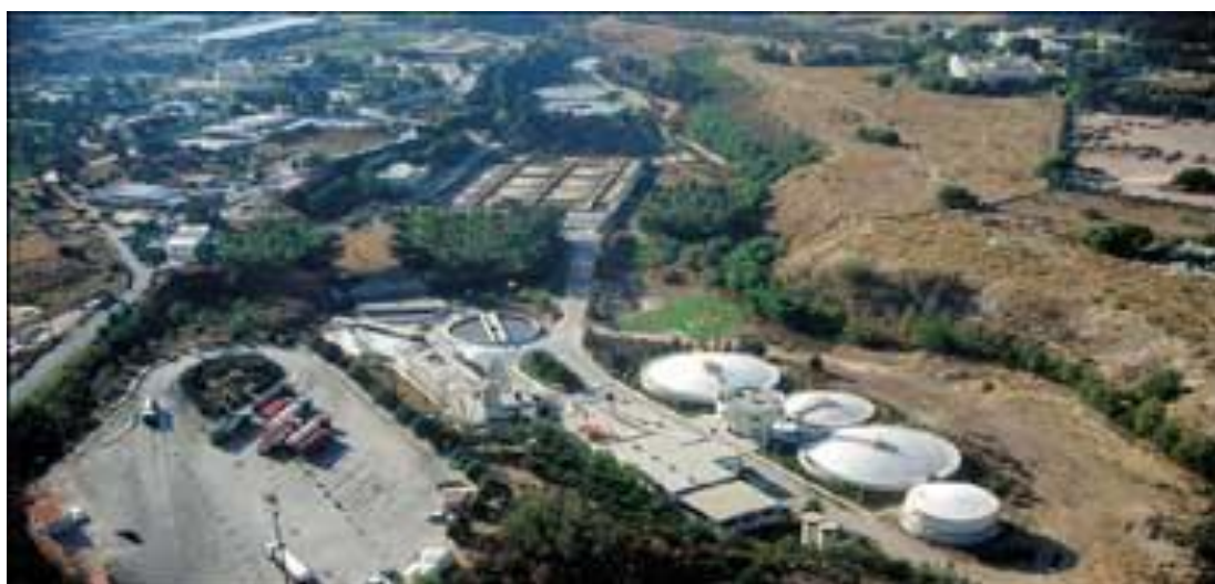
Εικόνα 4.2 Το Κέντρο Επεξεργασίας Λυμάτων Μεταμόρφωσης ( www.eydap.gr )
