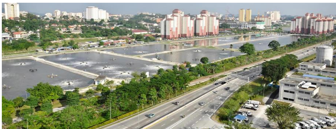
Εικόνα 3.12 Υπόγειο κέντρο επεξεργασίας λυμάτων Pantai2. Υπάρχουσα κατάσταση
