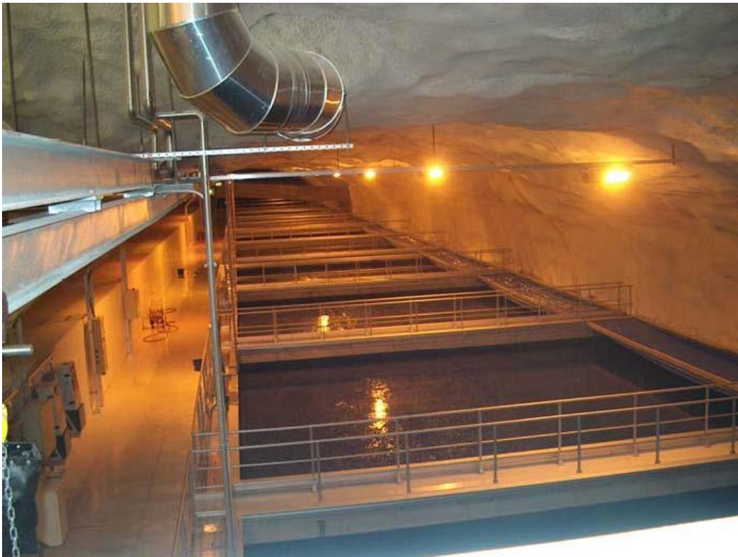
Εικόνα 3.9 Υπόγεια δεξαμενή του κέντρου επεξεργασίας λυμάτων Viikinmäki
