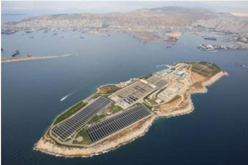
Εικόνα 3.1 Πανοραμική του Κέντρου Επεξεργασίας Λυμάτων Ψυτάλειας (Πηγή: www.eydap.gr )
