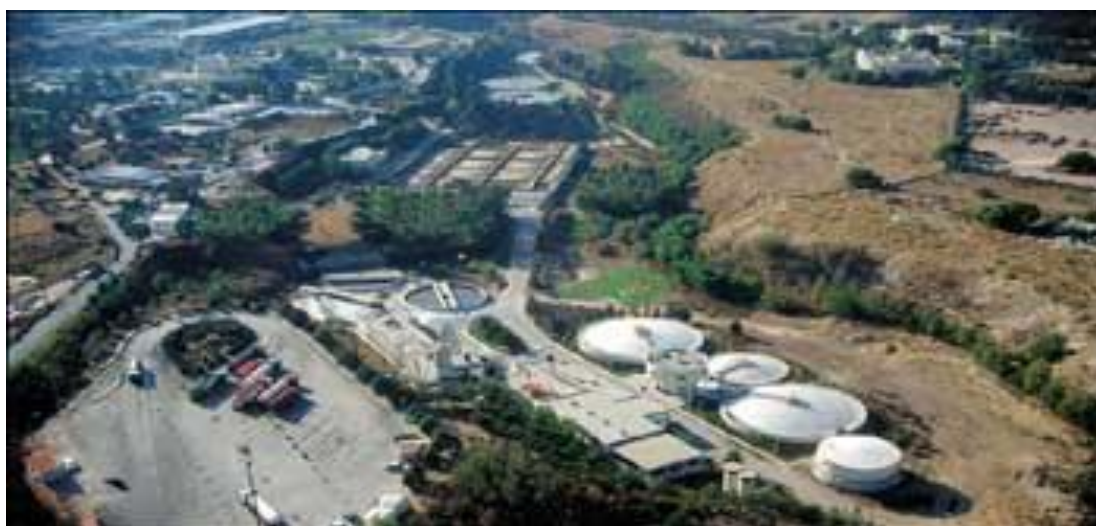
Εικόνα 4.2 Το Κέντρο Επεξεργασίας Λυμάτων Μεταμόρφωσης (Πηγή: www.eydap.gr )
