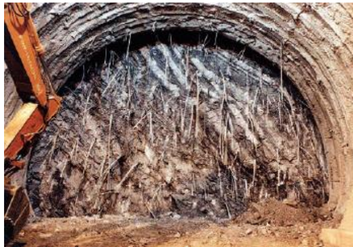
Εικόνα 2.2 Αγκύρια fiberglass στο μέτωπο εκσκαφής της σήραγγας
