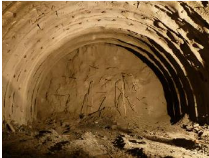
Εικόνα 2.1 Αγκύρια fiberglass στο μέτωπο εκσκαφής της σήραγγας
