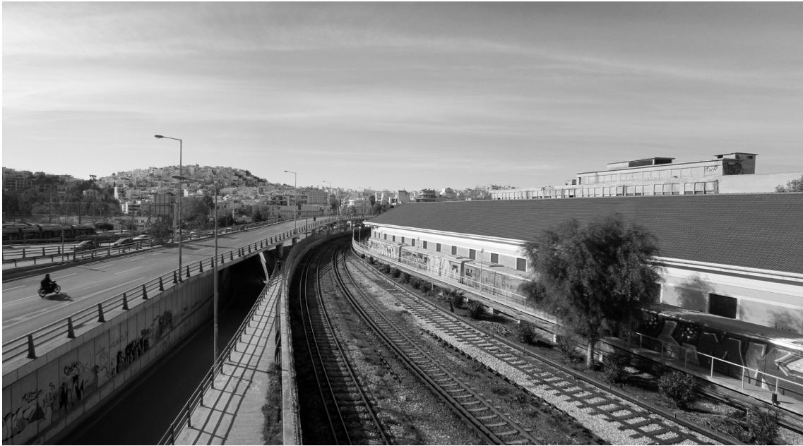
Εικόνα 32: Πανοραμική από πεζογέφυρα στο ύψος του σταθμού Νέου Φάληρου. Βλέπουμε τη σιδηροδρομική γραμμή (κέντρο και δεξιά) και δίπλα της τη λεωφόρο Ποσειδώνος (Αριστερά) η οποία μετά τη στροφή διαχωρίζεται, σε τμήμα ανόδου και καθόδου, και ακολουθεί το τρένο προς το λιμάνι.
