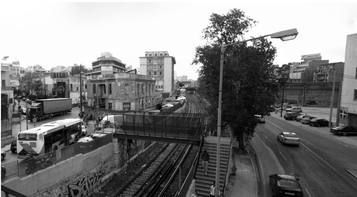
Εικόνα 33: Πεζογέφυρα στο ύψος της οδού Ηρώων Πολυτεχνείου. Λίγο πριν από αυτό το σημείο υπάρχει κόμβος που επιτρέπει την εγκάρσια προσπέλαση της σιδηροδρομικής γραμμής. Έτσι ο δρόμος συνεχίζει είτε προς το κέντρο του Πειραιά, μέσω της Η. Πολυτεχνείου (αριστερά), είτε προς το λιμάνι (δεξιά), μέσω της οδού Μικράς Ασίας- Αλυτέδου.
