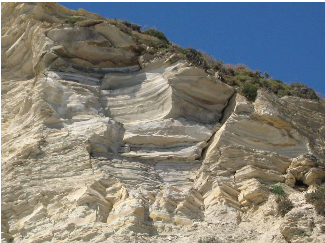
Εικόνα 4: Θέση αποκόλλησης (κοντινή άποψη) (φωτογραφία από Λουπασάκη 2008)
