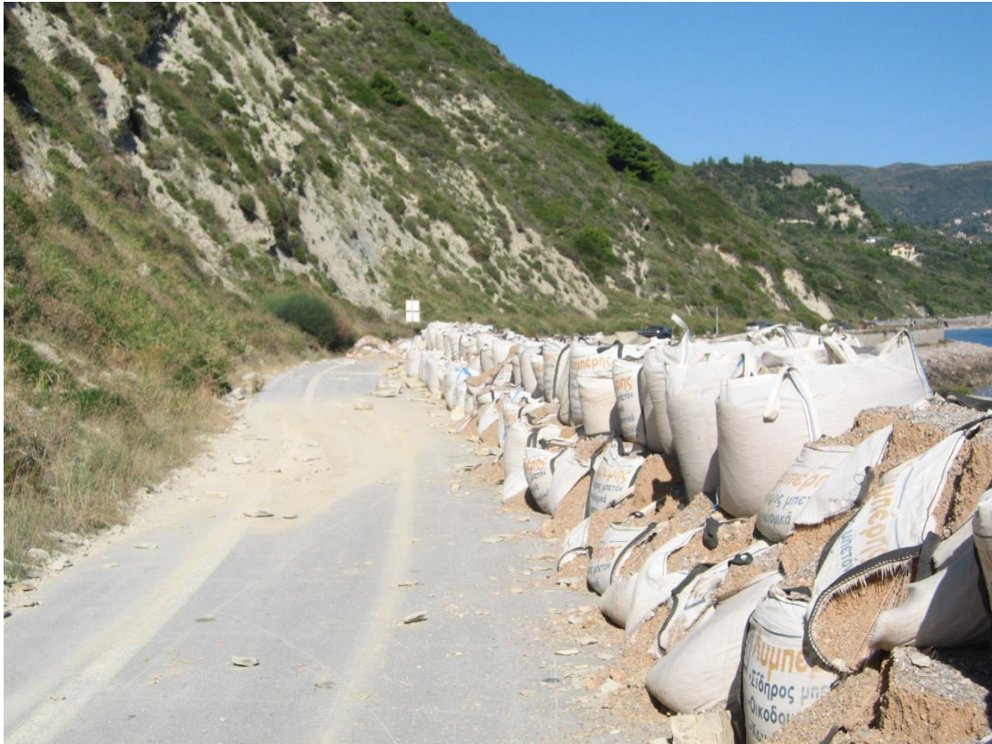
Εικόνα 5: Προσωρινά μέτρα προστασίας (φωτογραφία από Λουπασάκη 2008)
