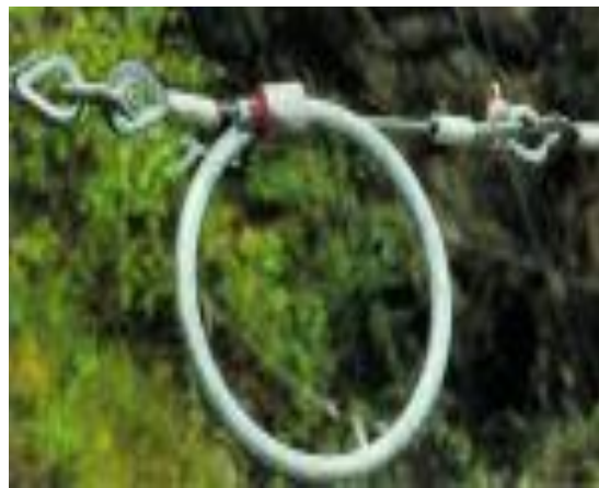
Εικόνα 5-15: Δακτυλιωτά φρένο, αποσβεστήρας ενέργειας
