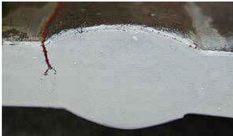
Διάβρωση με μηχανική καταπόνηση
