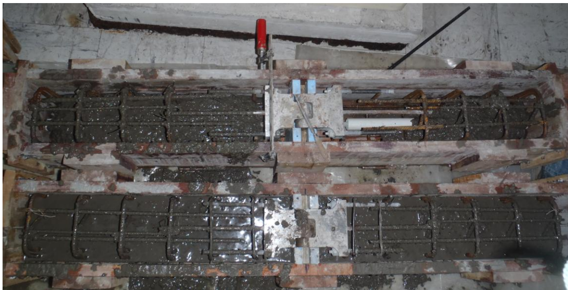
Σχήμα 3-5: Δοκίμια κατά τη σκυροδέτηση
