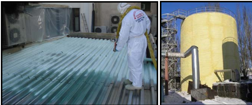
Εικ. 3.25: Εφαρμογή αφρού πολυουρεθάνης σε μεταλλική στέγη και βιομηχανική εγκατάσταση.
