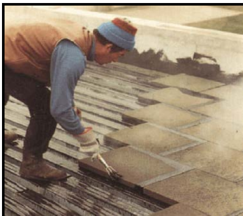
Εικ. 3.30: Τοποθέτηση πλακών αφρώδους γυαλιού σε δώμα.
