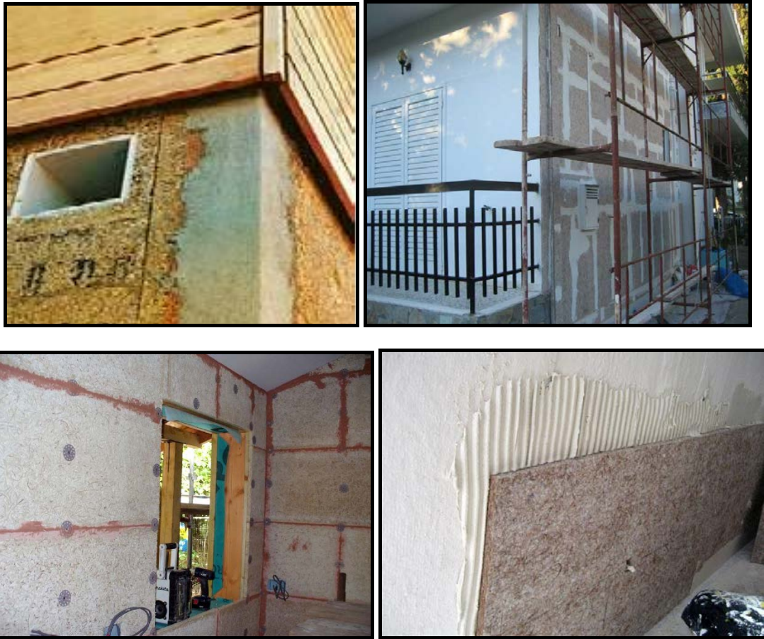
Εικ. 3.27: Εξωτερική και εσωτερική θερμική προστασία με ξυλόμαλλο.
