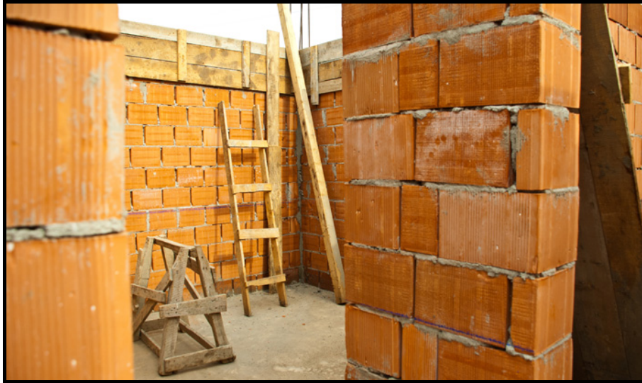
Εικ. 3.32: Κατασκευή από θερμομονωτικά τούβλα.
