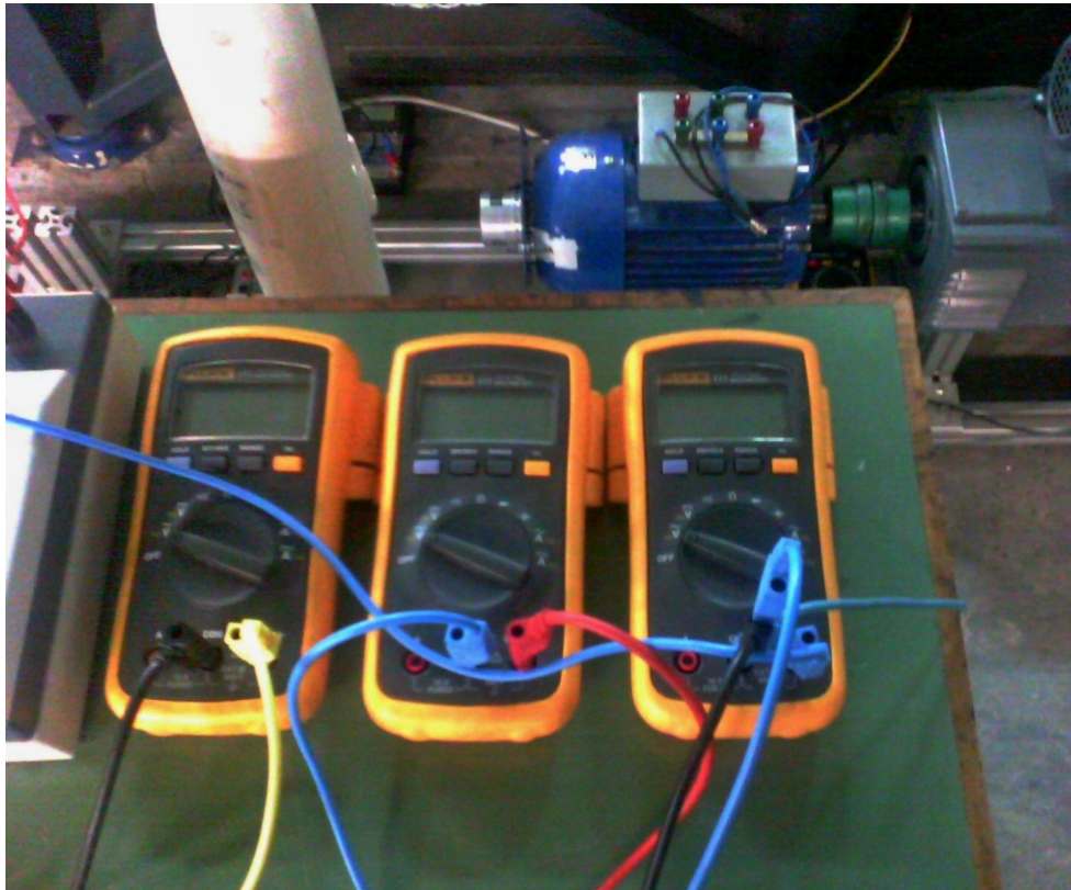
Σχ. 5.7 Πολύμετρα για τη μέτρηση των φασικών τάσεων των τυλιγμάτων
