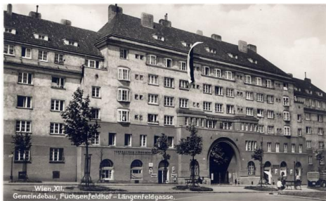
Όψη από τη Langenfeldgasse.
