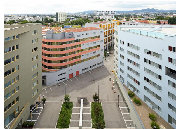
Εσωτερικές αυλές στο Kabelwerk
