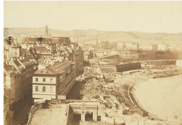
Η Βιέννη αμέσως μετά την κατεδάφιση του εσωτερικού τείχους
