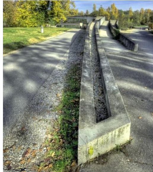
Εικ.45 η οροφή του κτηρίου ως συνέχεια της διαδρομής της φύσης
