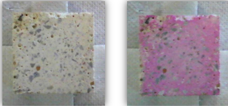
Σχήμα 6.19: Δοκίμιο A1 πριν και μετά τη δοκιμή ελέγχου ενανθράκωσης με φαινολοφθαλεΐνη
