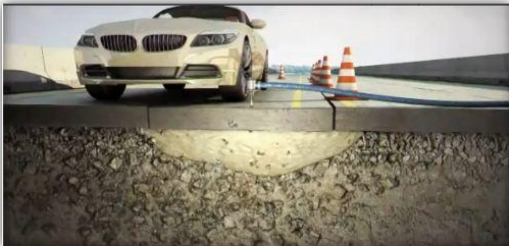
Σχήμα 1.19: Επιδιόρθωση δρόμου με έγχυση γεωπολυμερικού τσιμέντου
