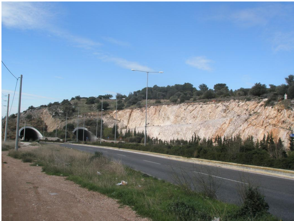
Φωτογραφία 9: Οι σήραγγες στην λεωφόρο Βάρης –Κορωπίου όπου δεξιά διακρίνεται μια τομή του κατώτερου μαρμάρου.
