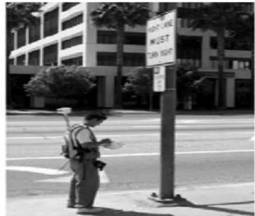
Σχήμα 9.1 Τυπικά παραδείγματα χρήσης συστήματος RTK-GPS σε εφαρμογές αποτύπωσης δρόμου
