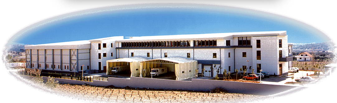
Σχήμα 6.2.α και 6.2.β: Οι εγκαταστάσεις της εταιρείας Hellenic Catering A.E στην Παλλήνη Αττικής
