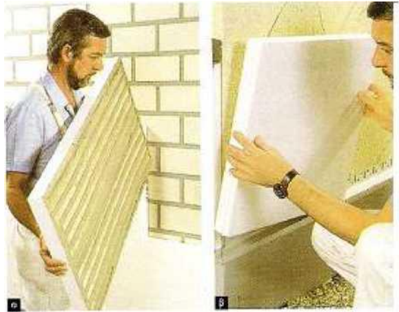
Τοποθέτηση πλακών διογκωμένης πολυστερίνης α) με κόλληση και β) με μηχανική στερέωση
