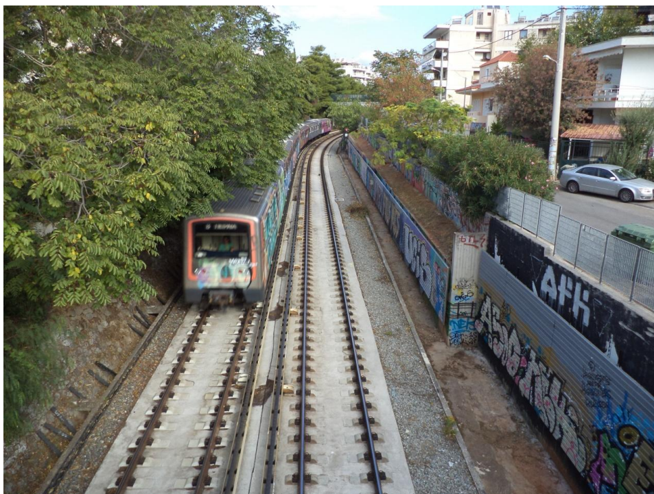
Εικόνα 4.6.2.7: Αποψη της κοίτης της σιδηροτροχιάς μετά την τοποθέτηση των πάνελ
