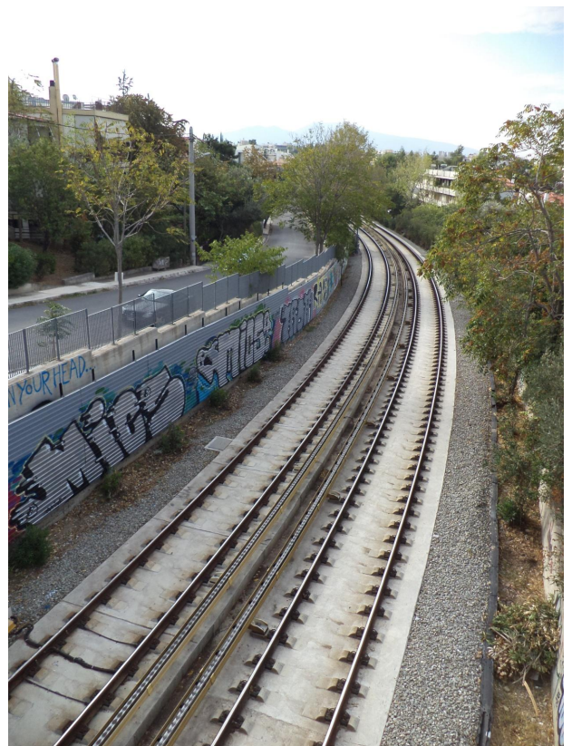
Εικόνα 4.6.1.8: Ίδια άποψη μετά την τοποθέτηση των πάνελ
