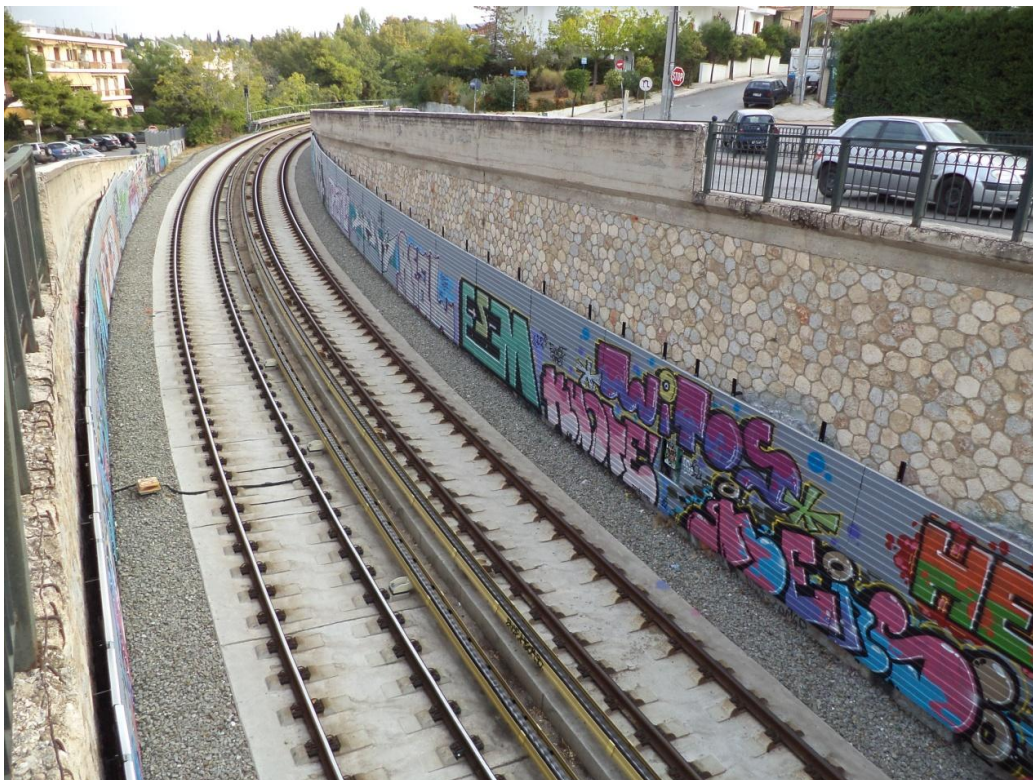
Εικόνα 4.6.1.4: Άποψη της σιδηροτροχιάς μετά την τοποθέτηση των ηχοαπορροφητικών πάνελ
