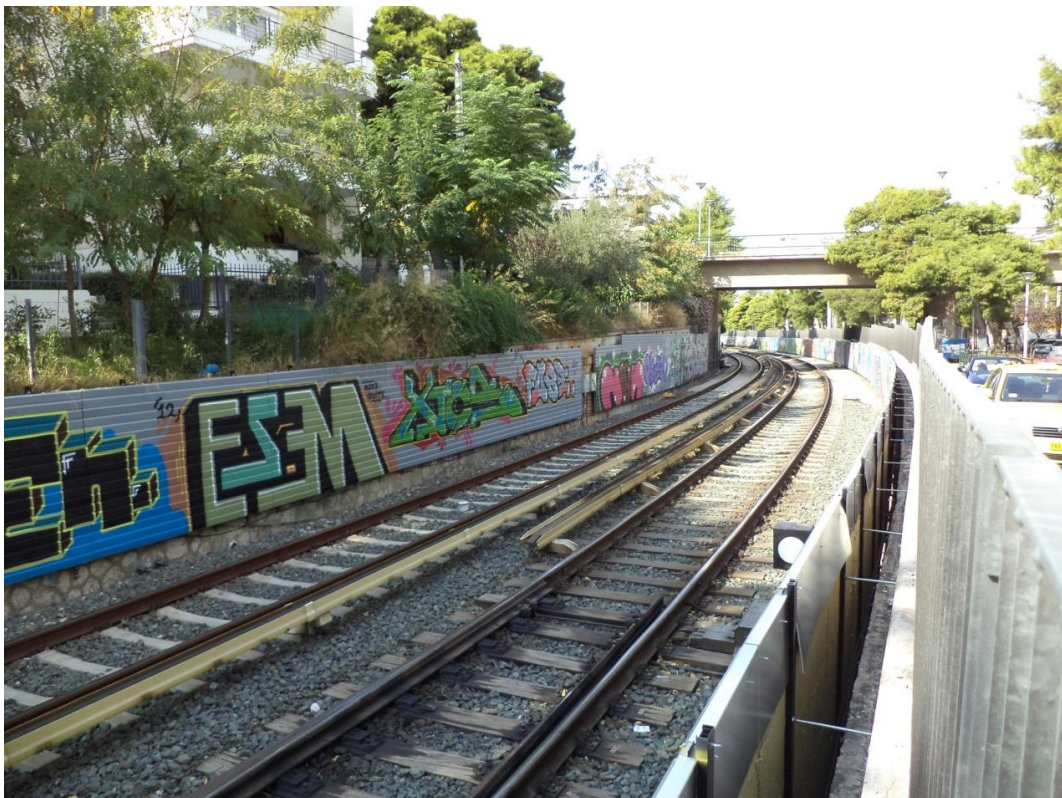
Εικόνα 4.6.3.7: Άποψη της σιδηροδρομικής κοίτης μετά την τοποθέτηση των ηχοαπορροφητικών
