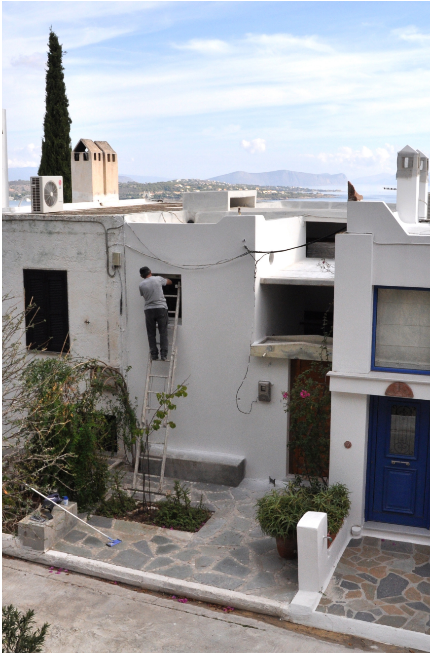
4.10 Έργα συντήρησης κατά την χειμερινή περίοδο.
