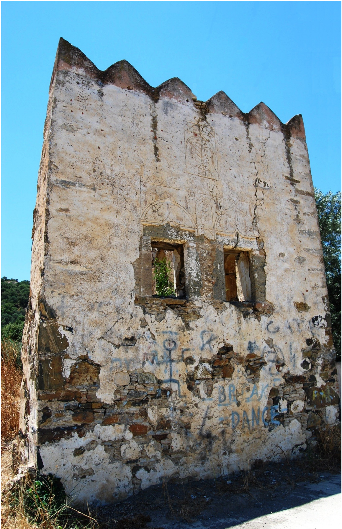
Εικόνα 5.8: Ο ανατολικός τοίχος του πυργόσπιτου, ο οποίος εφάπτεται της αγροτικής οδού
