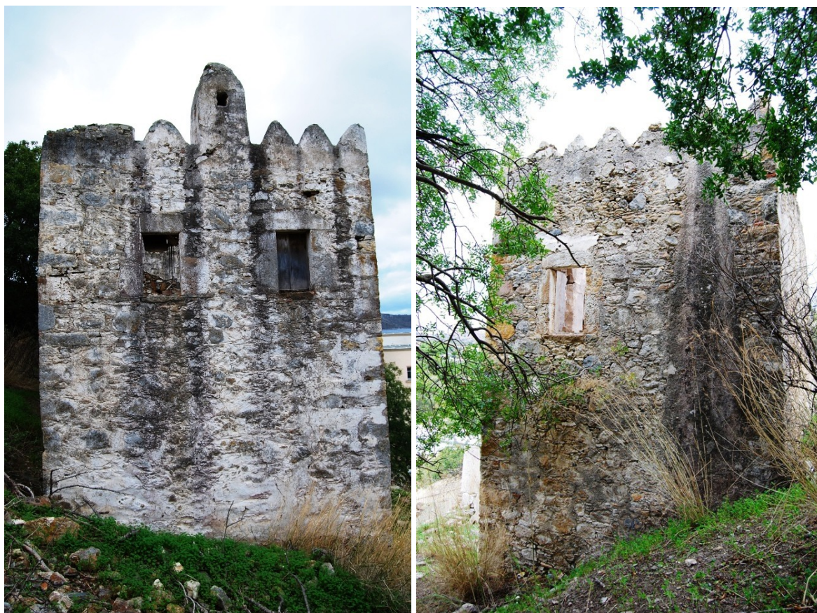
Εικόνα 6.21: Η βόρεια και η νότια όψη του πυργόσπιτου όπως είναι σήμερα
