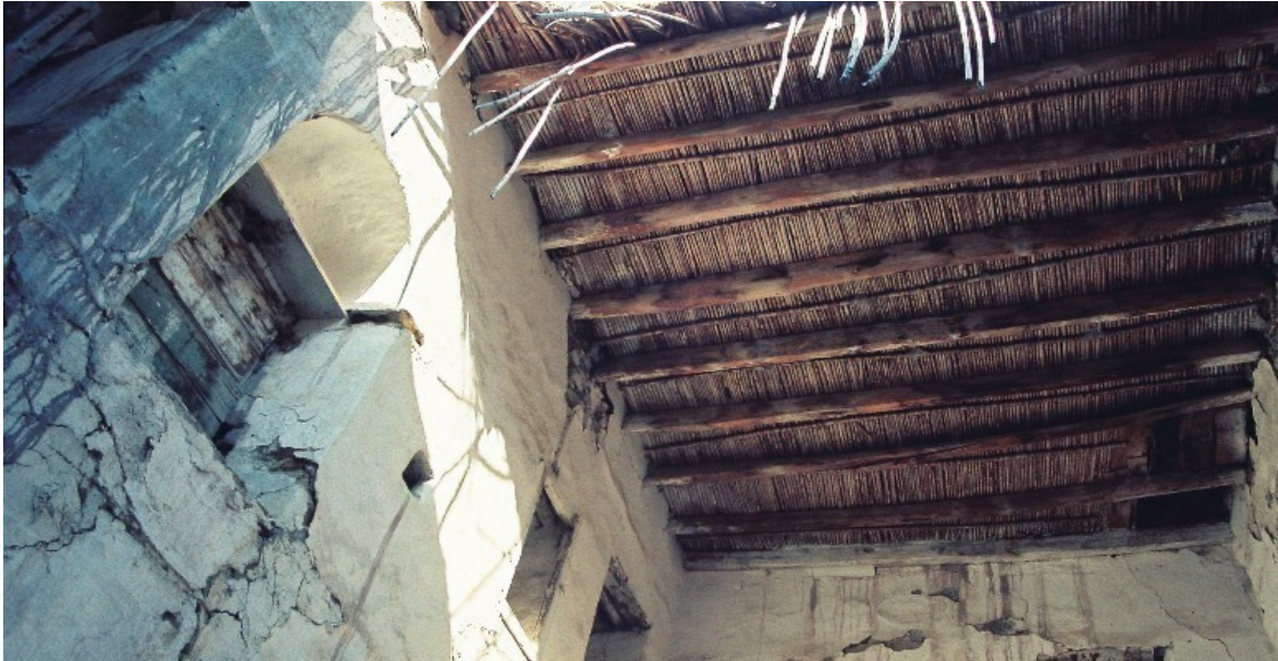
Εικόνα 6.27: Η στέγη με τις τράβες και τα καλάμια, όπως ήταν στα τέλη της δεκαετίας του '90
