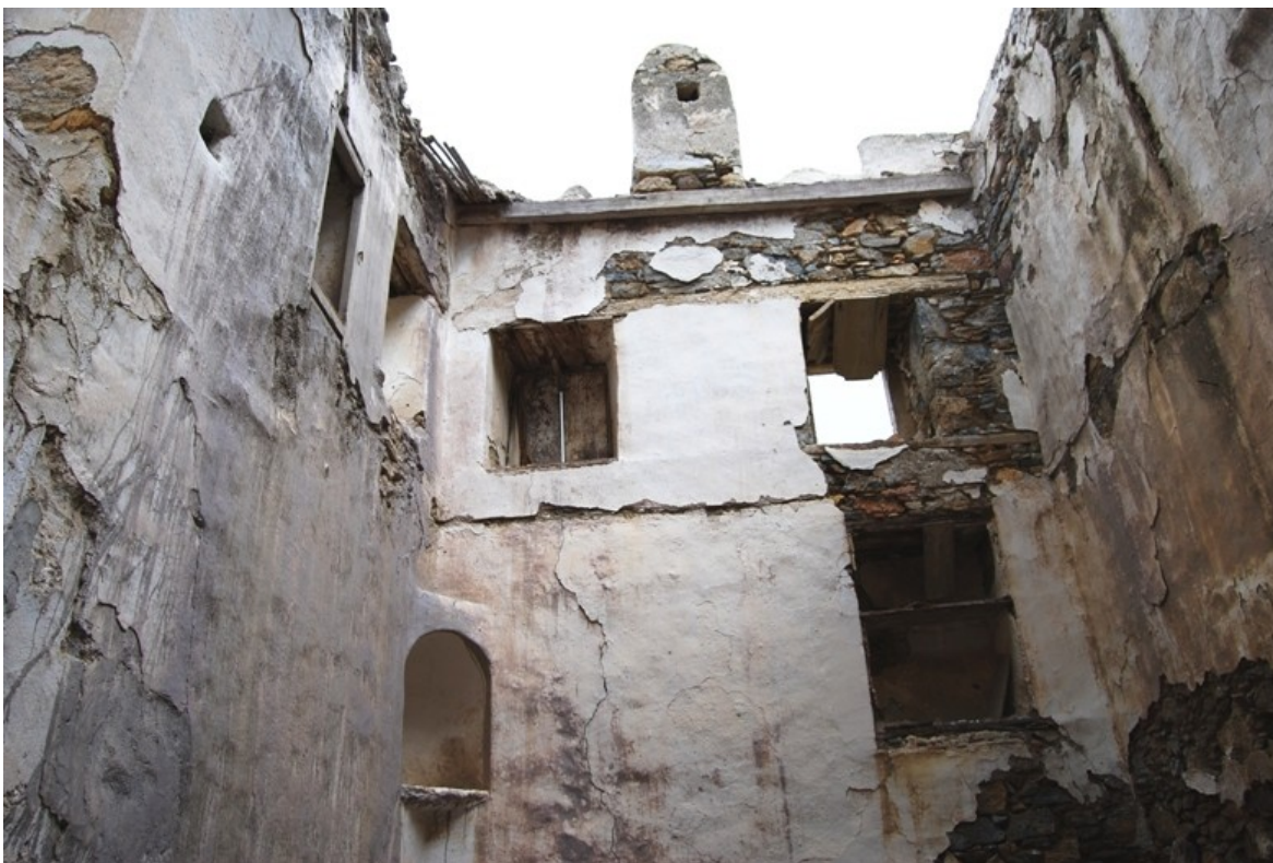
Εικόνα 6.26: Ο βορινός τοίχος: διακρίνεται το ίχνος του ψηλότερου παταριού με τα τρία ανοίγματα και το εσωτερικό τμήμα της καταχύστρας (αριστερά)
