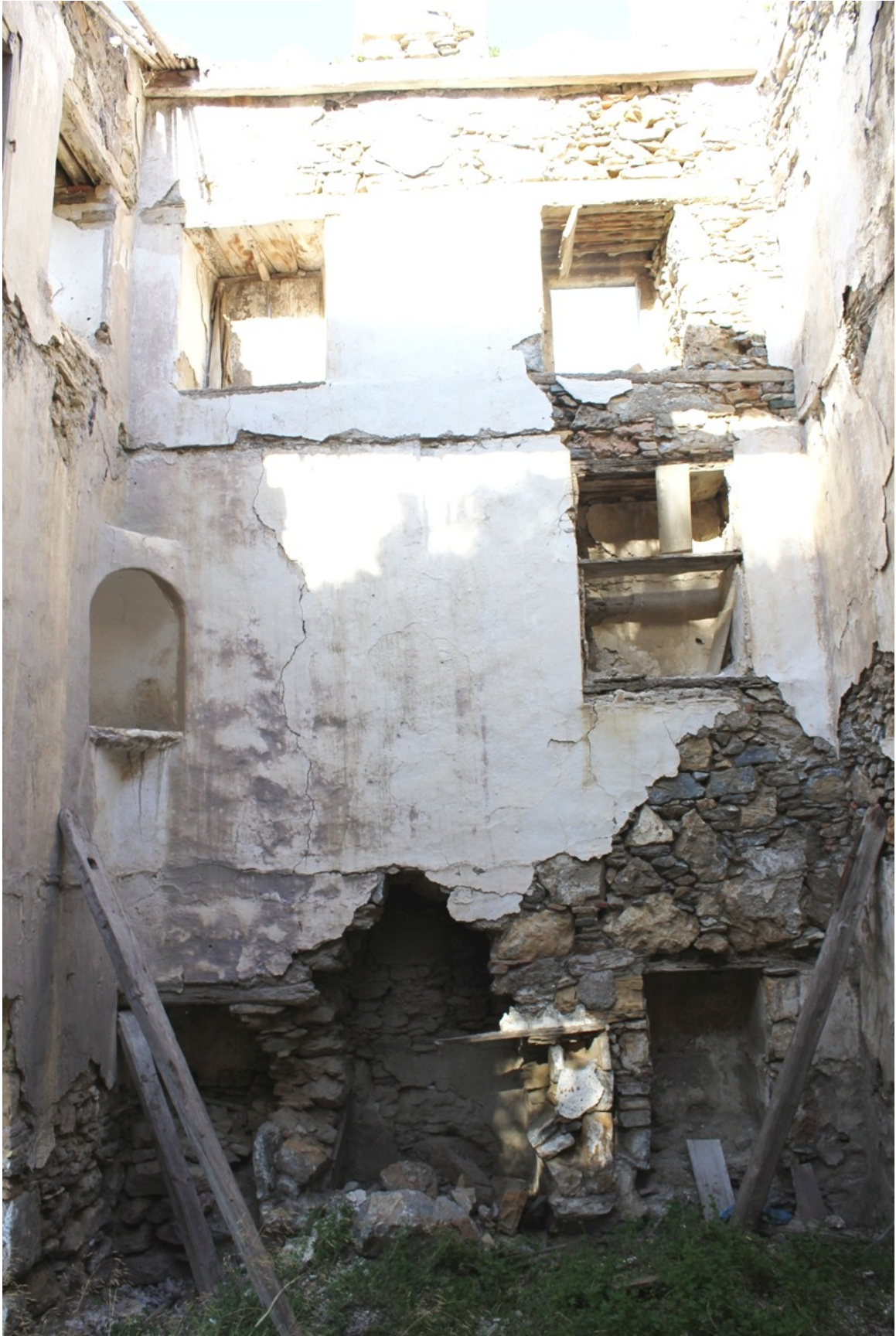
Εικόνα 6.22: Η βορινή πλευρά του ισογείου. Διακρίνονται: το τζάκι με τις εκατέρωθεν εσοχές, τα ίχνη του ορόφου και του παταριού, ο γωνιακός λυχνοστάτης, η μεγάλη εσοχή και τα ανοίγματα ψηλότερα
