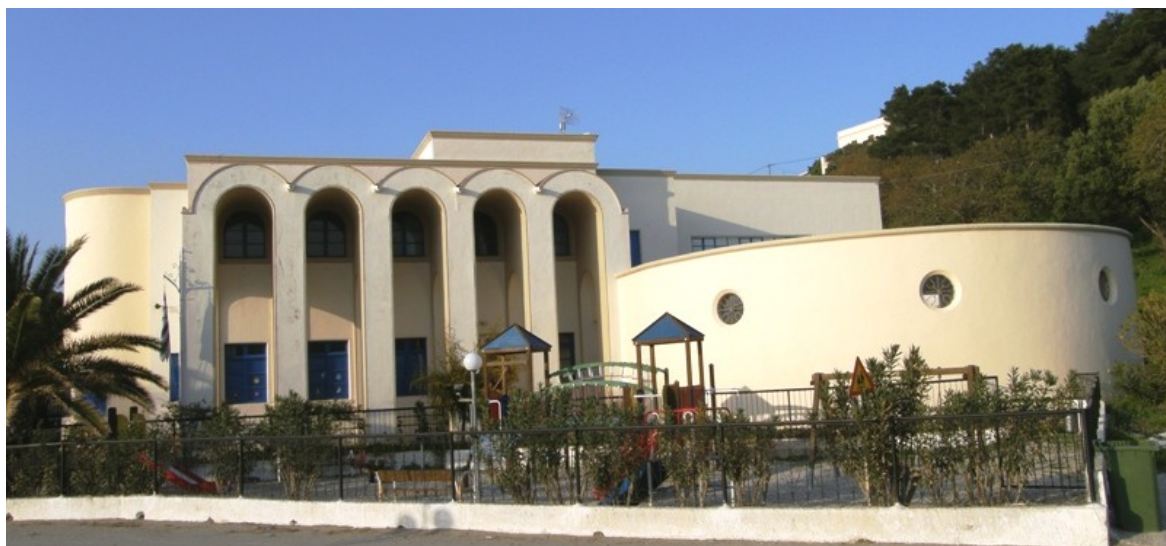
Εικόνα 6.8: Η νότια όψη του Δημοτικού Σχολείου Λακκίου, στα ανατολικά του οποίου βρίσκεται το πυργόσπιτο
