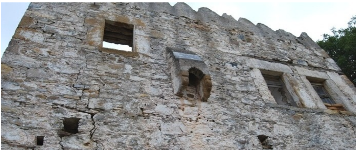
Εικόνα 6.14: Το ανώτερο τμήμα της δυτικής όψης, με την καταχύστρα και τα τρία ανοίγματα. Διακρίνονται και δύο από τις τρεις οπές στήριξης της πέργολας
