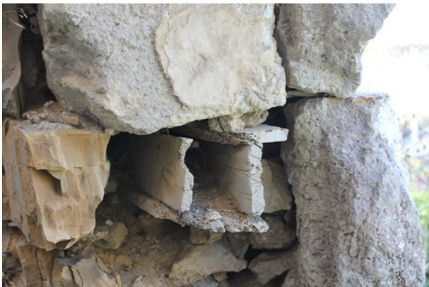
Εικόνα 6.17: Η νότια κοιλότητα όπου ασφάλιζε η οριζόντια μπάρα της εισόδου
