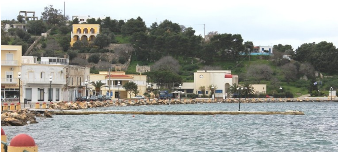
Εικόνα 6.11: Η ανατολική, παραλιακή περιοχή του Λακκίου. Δεξιά το σχολείο, στο κέντρο, πίσω από το ιταλικό κτίριο, το πυργάκι και ψηλότερα το αρχοντικό της οικογένειας Ρούσσου
