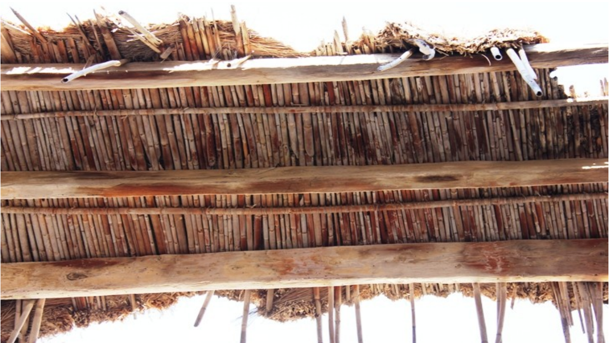
Εικόνα 6.28: Ό,τι έχει απομείνει σήμερα από τη στέγαση του κτίσματος
