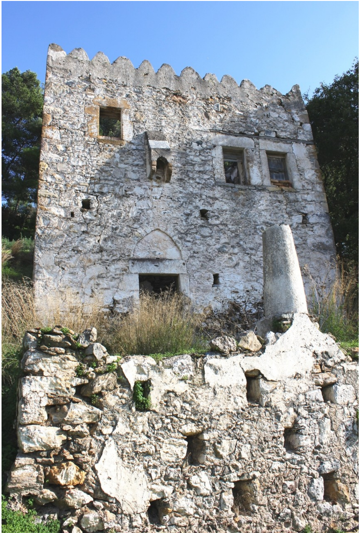
Εικόνα 7.5: Το πυργάκι από Δ με τον αναλημματικό τοίχο της αυλής και ένα από τα τρία πήλιαστρα, τα οποία στήριζαν τη μεταγενέστερη κρεβατίνα (πέργολα)
