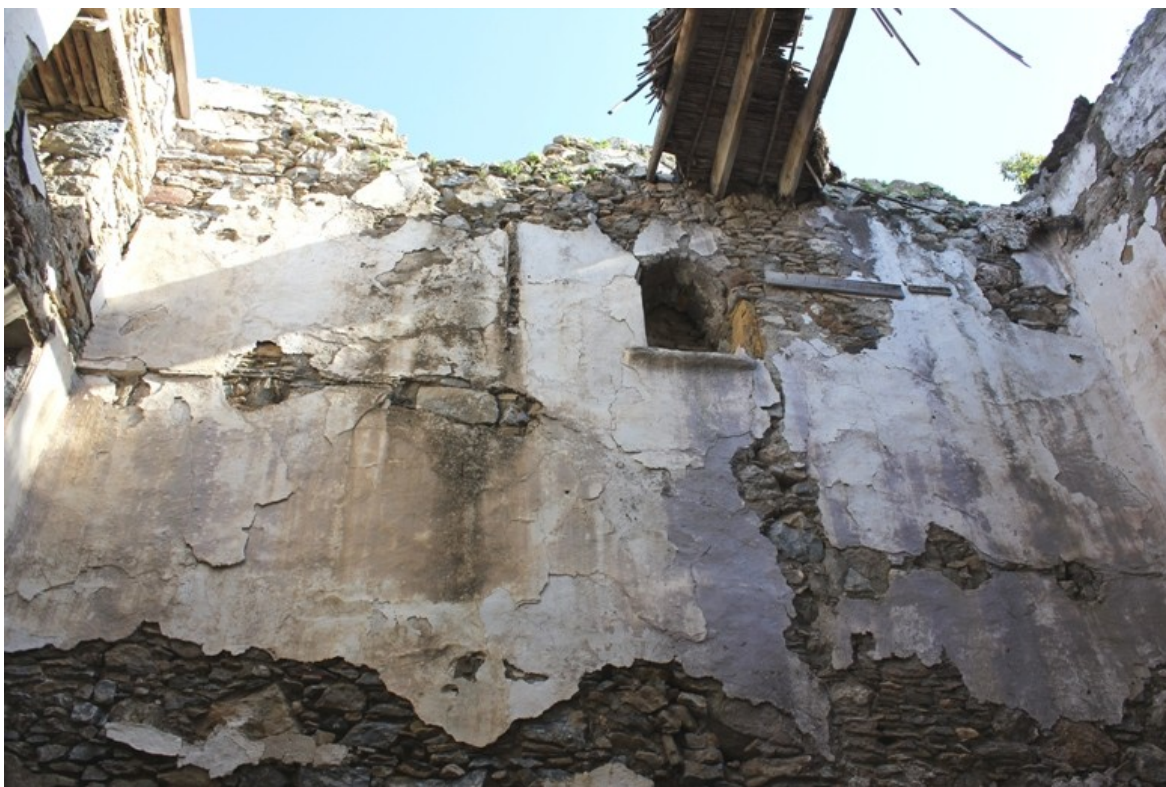
Εικόνα 6.25: Ο ανατολικός τοίχος, με τη μικρή εσοχή-λυχνοστάτη, τα ίχνη των δύο παταριών και της δεύτερης μικρής σκάλας
