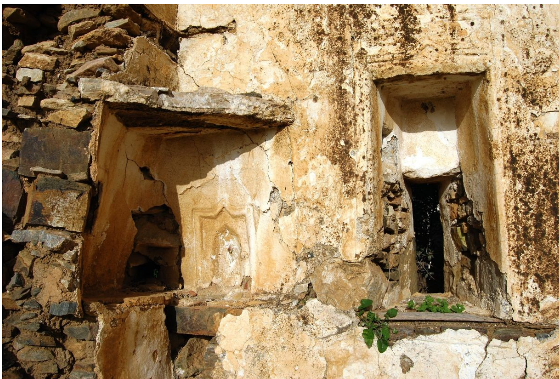
Εικόνα 5.13: Η γωνιακή εσοχή του νεροχύτη και δεξιά της η τουφεκότρυπα
