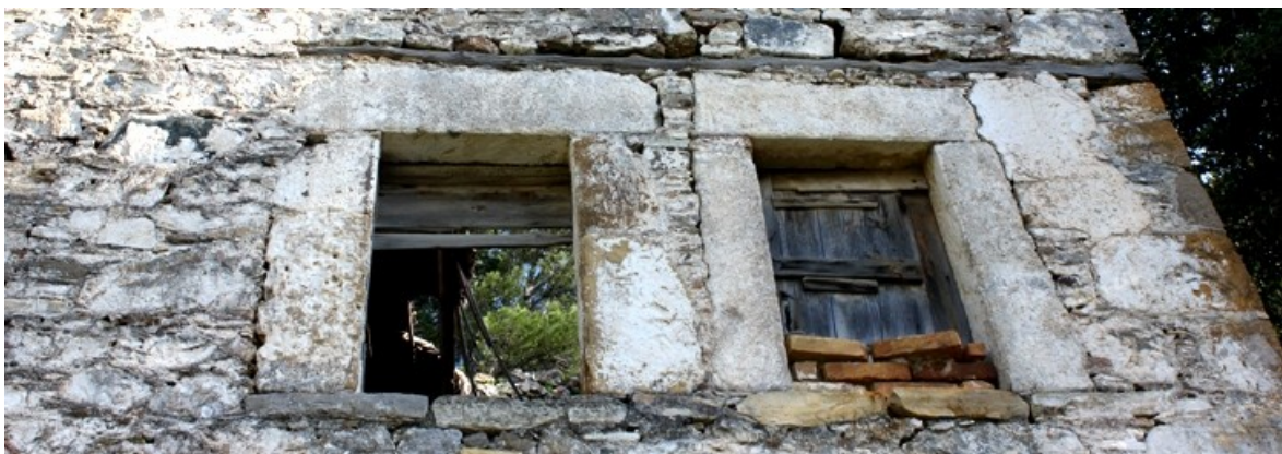
Εικόνα 6.19: Τα δύο ανοίγματα της πρόσοψης με τα ακανόνιστα μαντώματα από πωρόλιθο,
